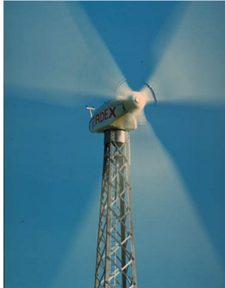
Fig. I.7. Pylône en treillis.
