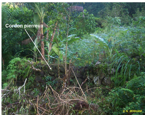
Photo 67- Murette en pierres sèches pour le maintien du sol
