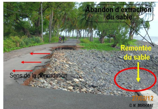
Photo 64- Remontée du sable et dégradation continue de la route après abandon d'extraction du sable
