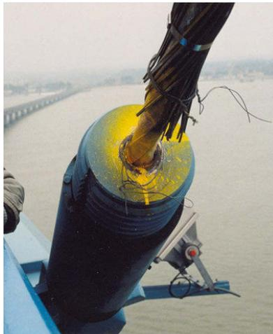
FIGURE 1.6 – Endommagement d'un hauban par fretting-fatigue [19]
