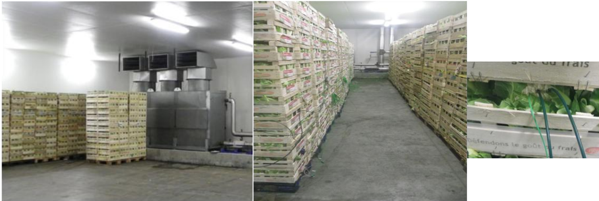
Figure V.1 : Vue du hall de conditionnement en cours de chargement, de la travée instrumentée et de l'instrumentation d'un chou-fleur.
