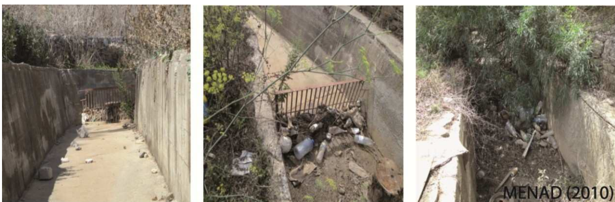
Fig. 7.4. Canal à ciel ouvert situé en amont de l'ouvrage hydraulique de réception.
