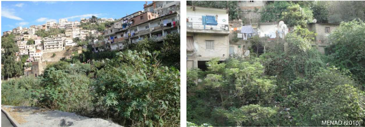
Fig. 7.20. Clichés pris sur la rive gauche du sous-bassin-versant de Sidi Medjber.
