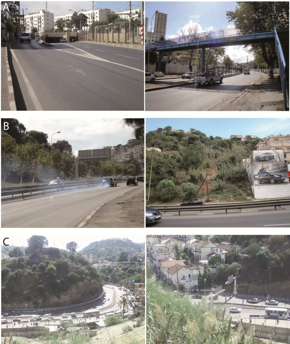
Fig. 7.32. Environnement urbain autour de la voie rapide Chevalet-Triolet (A). Partie amont. (B). Bassin moyen. (C). Partie aval.
