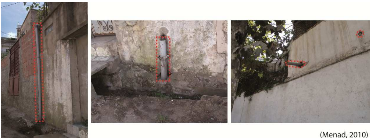
Fig. 8.8. Système de récupération et d'évacuation des eaux pluviales ruisselant sur les toits dans le bassin-versant de l'Oued Koriche.
