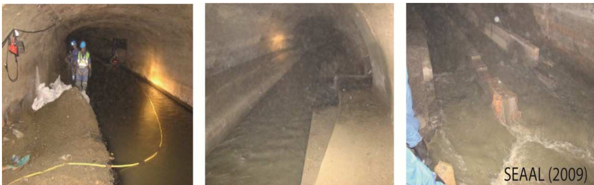
Fig. 7.13. Travaux de curages à l'intérieur du collecteur Oued M'Kacel.
