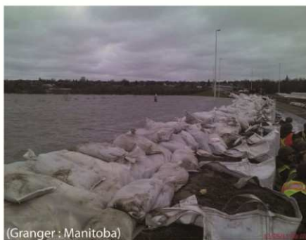
Fig. 8.9. Dispositifs de protection : batardeaux, sacs de sables.
