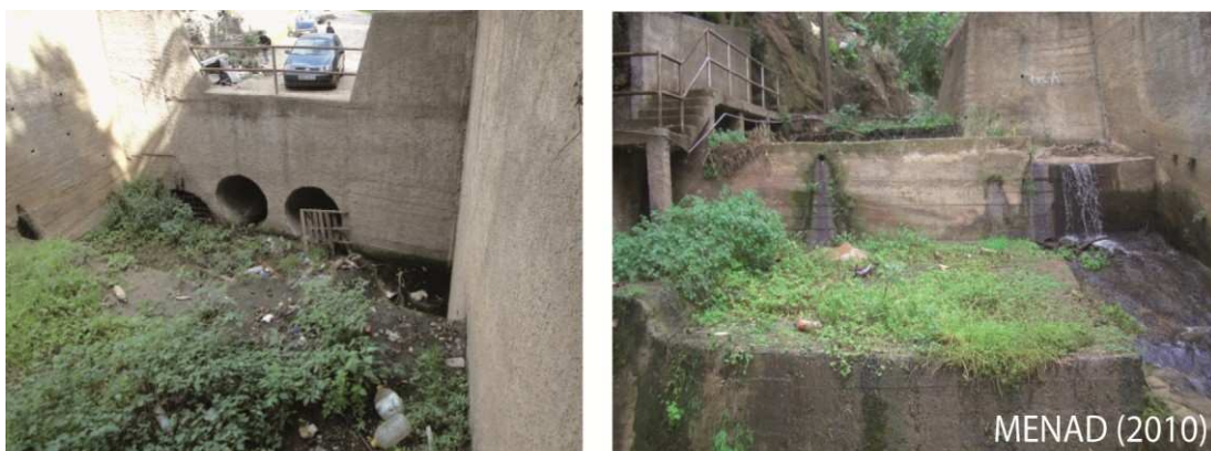
Fig. 7.11. Ouvrage hydraulique Chemin du Fort.
