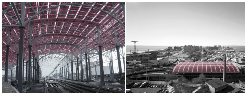
Fig. 17 Energie solaire utilisée dans la station du métro de New York Coney Island (Etat-Unis)
