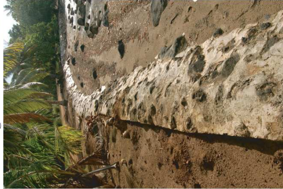
Ouvrage bien construit
