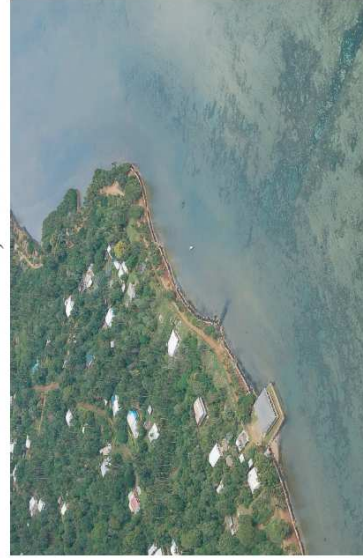
Murs côte nord, vue du ciel
