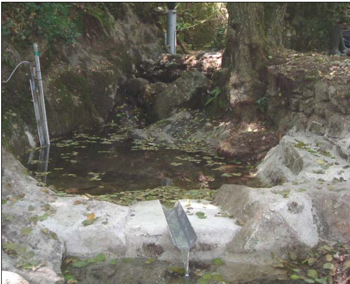
Photo 2.1 - Station du Cartaou réaménagée.
