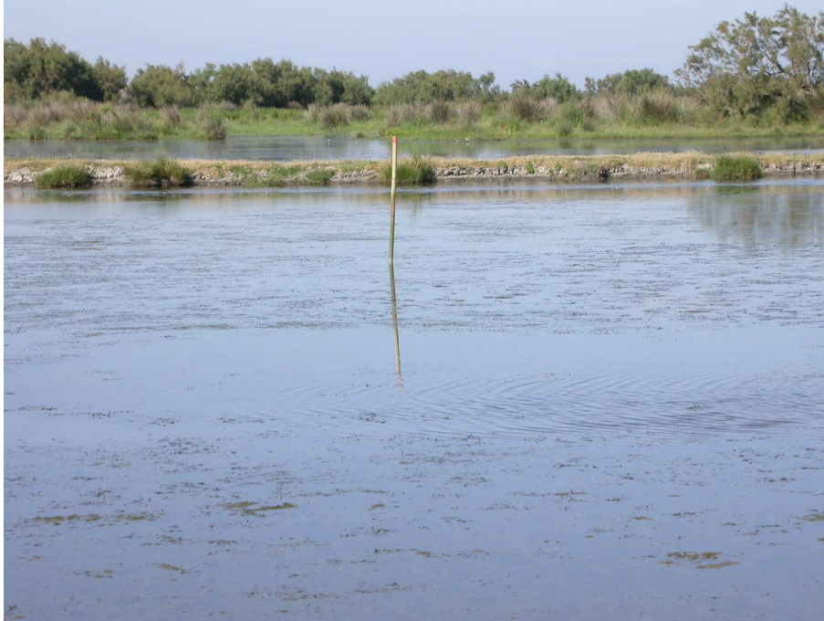
Aménagement en parcelles (digue au centre de l'image)
