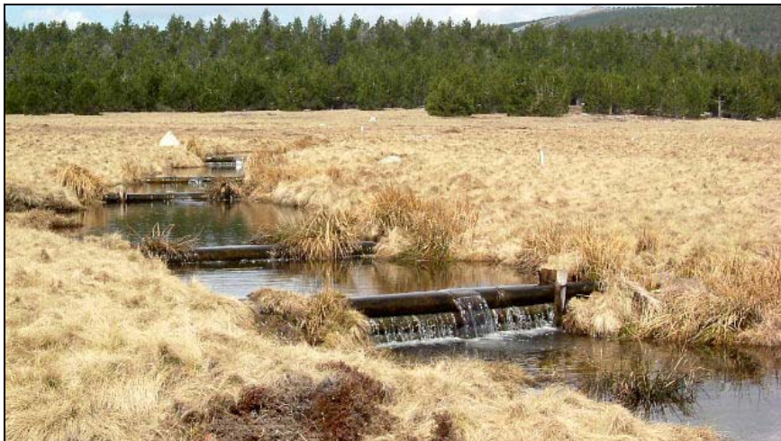
Photo 2 - Série de barrages-seuils dans la partie amont de la Plaine de la Sénégrière.
