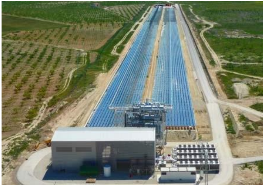
Figure I-17 . Centrale de Puerto Errado 1 (PE1, Novatec)
