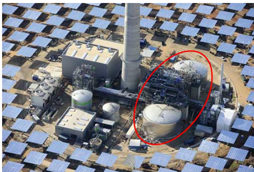
Figure I-6. Les deux réservoirs de stockage de la centrale Gemasolar.
