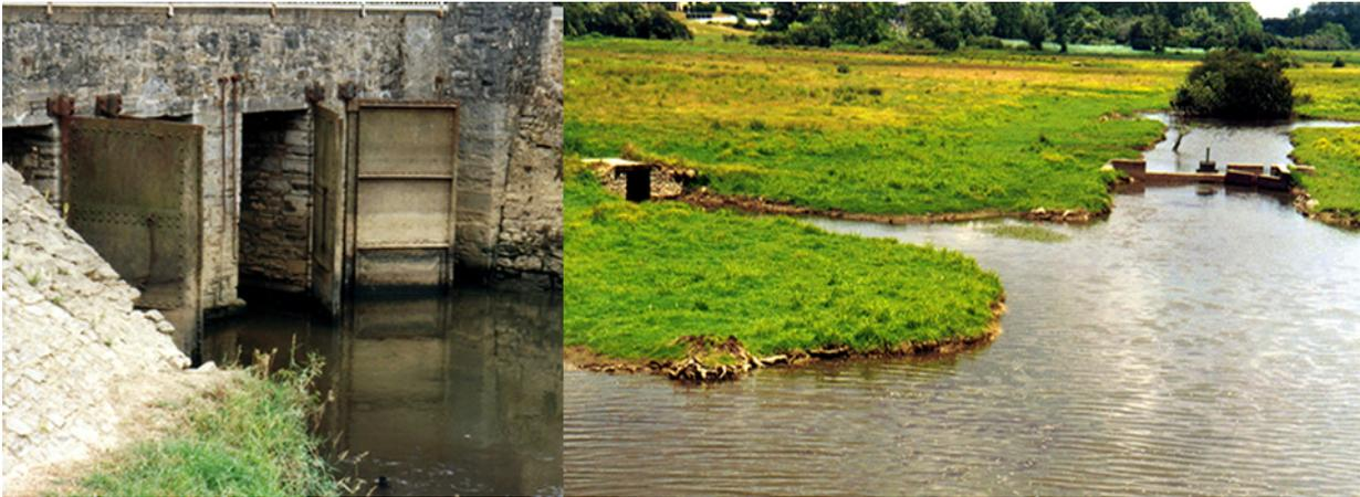
Figure 49 : Un exemple de portes à flots et un système d'esteys
