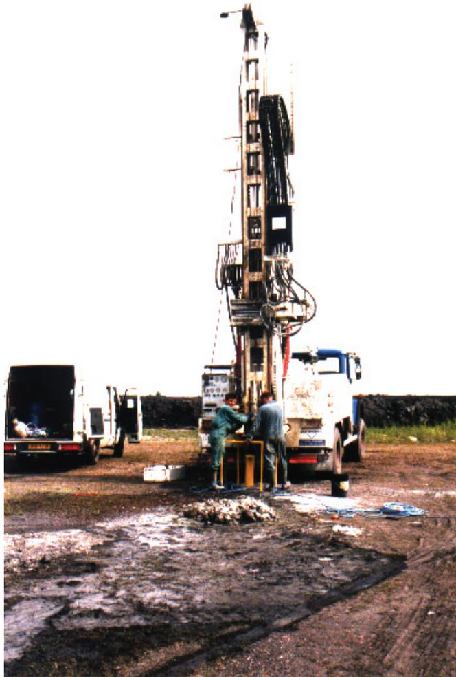
**Photo 5 :** Foration et installation de piézomètres
