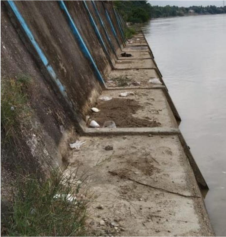
Gambar. 6 kondisi pinggiran sungai di stasiun 4
