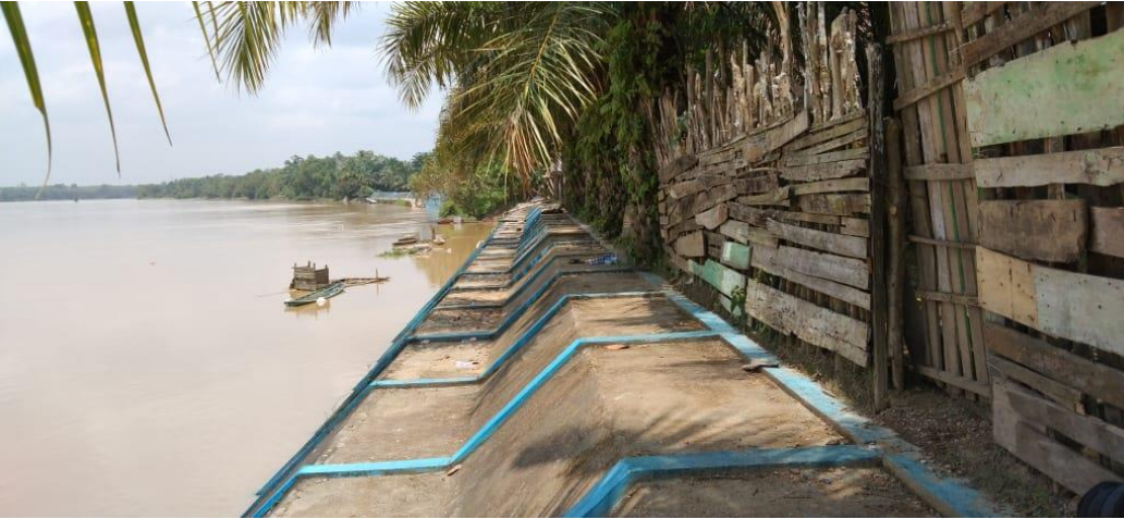
Gambar. 15 kondisi pinggiran sungai di stasiun 13
