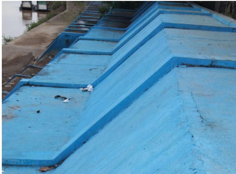
Gambar. 8 kondisi pinggiran sungai di stasiun 6
