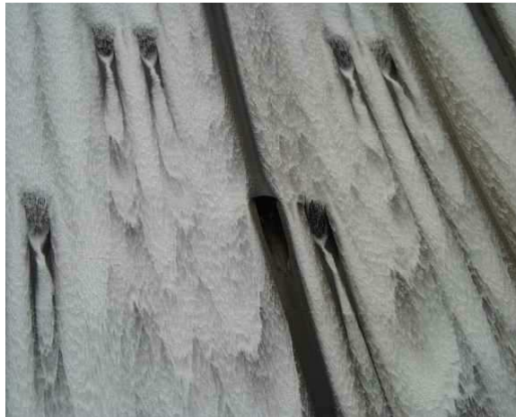
FIG. 2.1 – Roll waves dans un déversoir de barrage (Reddin, Californie, USA).
