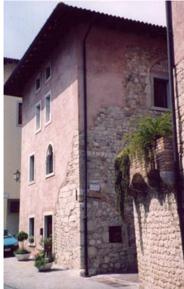
Cliché 3.1. A Gémone, un édifice reconstruit en conservant les traces de l'ancien bâtiment.
