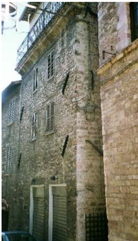
Cliché 2.4. Consolidations parasismiques sur un bâtiment à Assise.
