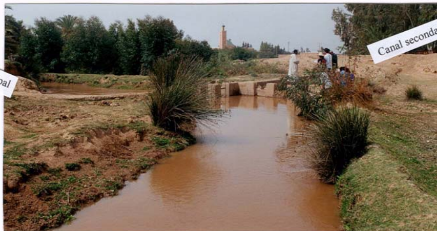
Photo I-2 : Lieu de dérivation vers une canal secondaire sur une seguia (Tamezglift) L'amazzal (en djelaba blanche) explique le tour d'eau aux étudiants
