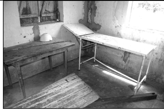
Photo 2. Dispensaire de Massina, construit en 1960, jamais réhabilité depuis (département du Pool, district de Kimba)
