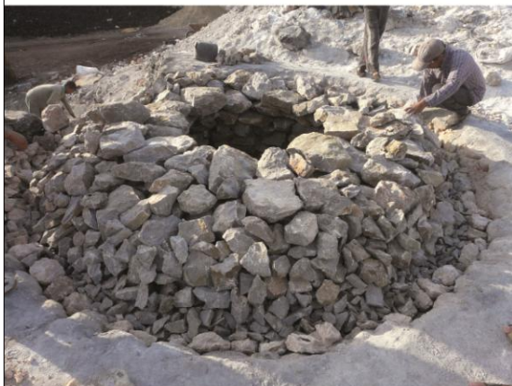
Fig. 11: Voûte en cours de construction (Aïn Lansarine, E57, 2008 - cl.: Chr. Vaschalde).
