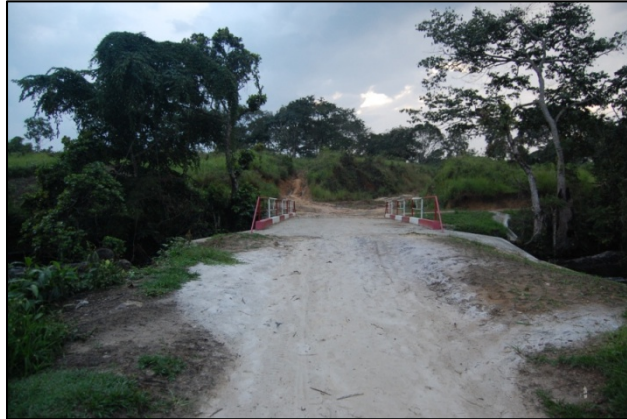
Photo 13. Un pont nouvellement construit permet l'arrivée par le sud à Vinza-centre
