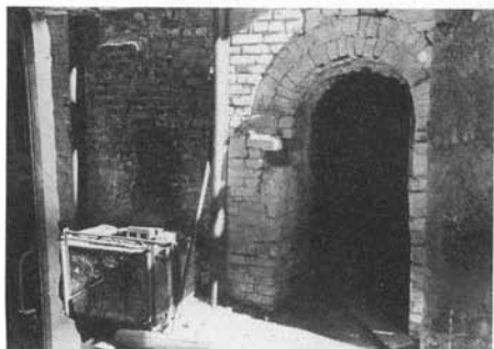
Briquetterie Ducros Schéma des installations. Plan et coupe transversale du four principal. Bâtiment d'habitation. Second four à briques. Porte de chargement et alandier du four principal.
