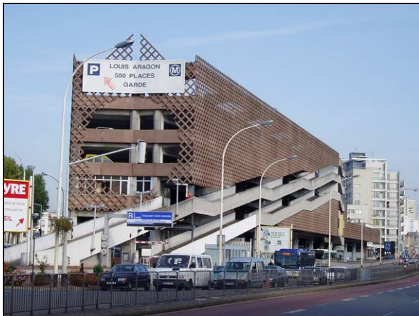
Figure 38 –Vue du pôle de Villejuif Louis Aragon depuis la RN 7.
