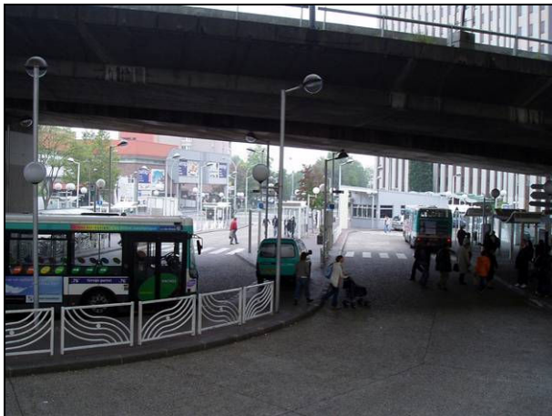
Figure 14 – Présence de l'échangeur de l'autoroute A3 en surplomb de la gare routière.
