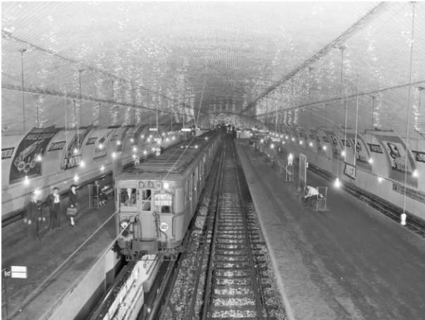
Anciens quais de la ligne 9 avec un système d'éclairage au moyen d'ampoules suspendues. Station Porte de Montreuil.
