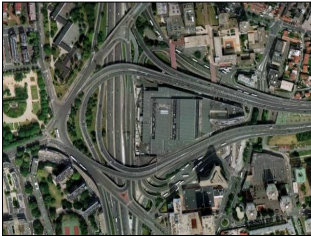
Figure 7 – Photo satellitaire de l'échangeur A3 surplombant le pôle de Gallieni.
