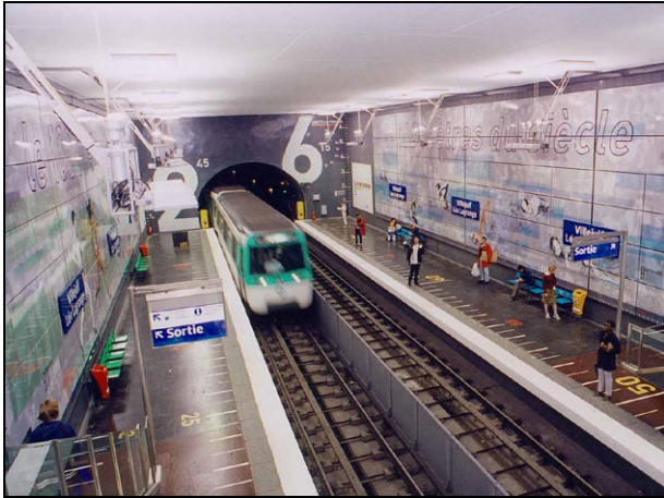
Figure 58 – Vue des quais de la station Villejuif-Léo Lagrange – ligne 7.
