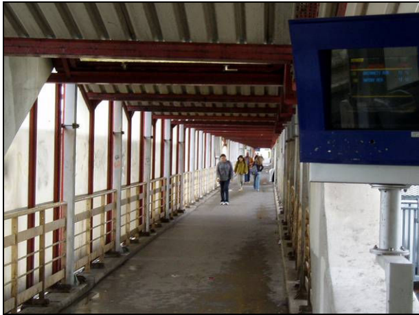
Figure 19 – Passerelle reliant les deux gares de RER de Massy-Palaiseau.
