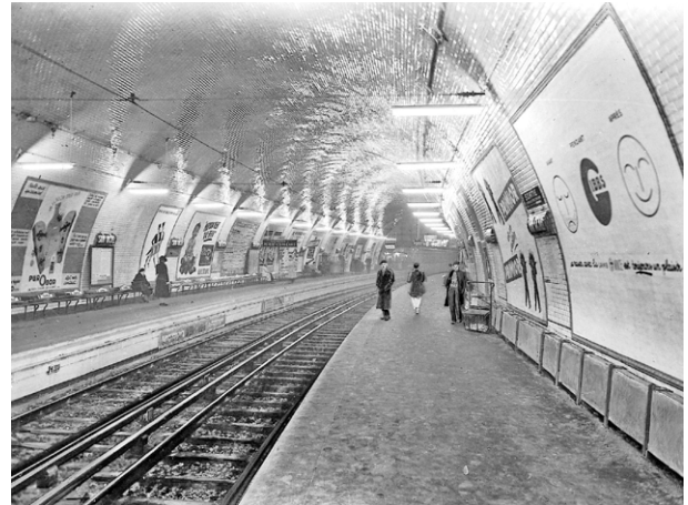
Eclairage au néon de la station Saint-Michel (ligne4)
