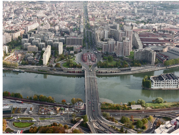
Figure 28 – Vue aérienne du pôle de Pont de Sèvres
