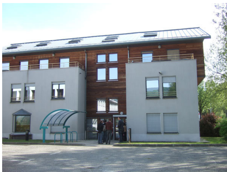
Figure 25. Siège de INDDIGO (Chambéry), une des entreprises les plus engagées dans le cadre de l'expérimentation SD 21000 (crédit photo : INDDIGO)
