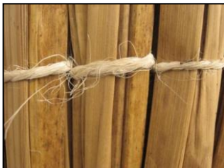
Foto 20. Estera de totora. Detalle de amarre de fibra con cuerda de fique.
