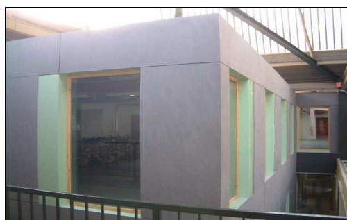
Figure 25. Un aperçu du bâtiment PREDIS
