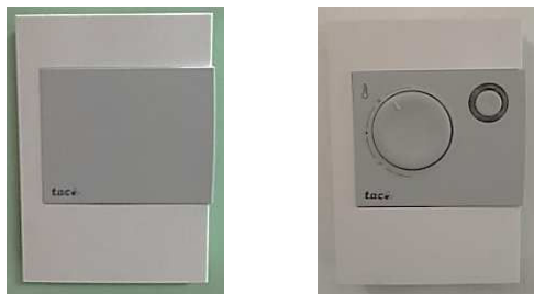
Figure 2-23. Capteurs de GTC
