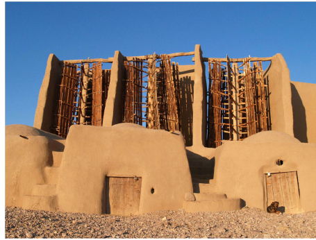
Figure V.2: Eolienne verticale à Nishtafun en Iran (600 AD).
