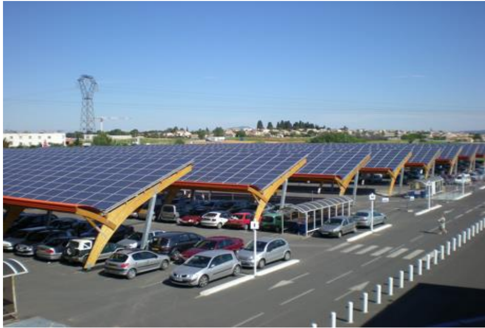
Figure IV.13. Parking recouvert de panneau photovoltaïque au centre commercial E. Leclerc de Saint-Aunès
