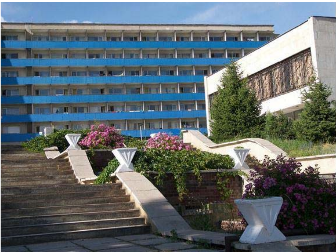
Photo : La maison de repos « Ak-Tolkun », un établissement étatique qui appartient à différents ministères (par ex. : les 5 e et 6 e étages appartiennent au ministère de l'Approvisionnement, d'autres étages aux autres ministères, etc.).
