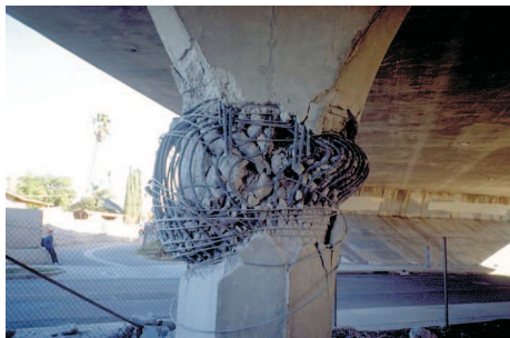
(c) Passage inférieur à l'autoroute Simi-Valley-San Fernando, Northridge (1994) (Photothèque FHWA).
