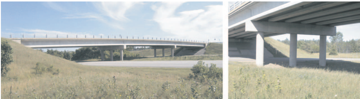
Figure 3.1 – Pont Chemin des Dalles : vue d'ensemble et vue d'un appui [89].
