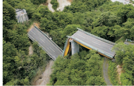
(b) Pont effondré à la suite du séisme Iwate-Miyagi Nairiku, Japon (2008) (Wiki Commons).
