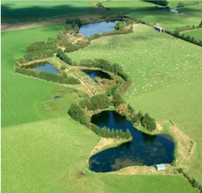
Figure 3.9 : Marais filtrant intégré (MFI) (Tirée de : Department of Agriculture, Minnesota state, 2013 )
