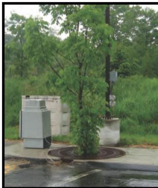
**Figure 2.5 : Boîte à arbre filtrante.** (Tiré de : UNSCH, 2009, p22.)
