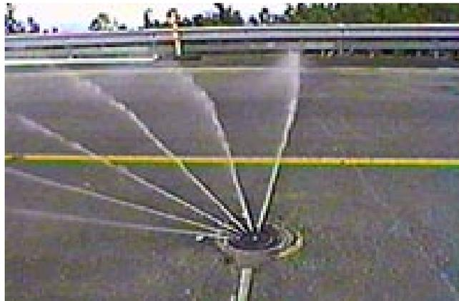
Figure 2.9 Système d'arrosage automatique fixe (FAST). Tiré de MTO, 2001.
