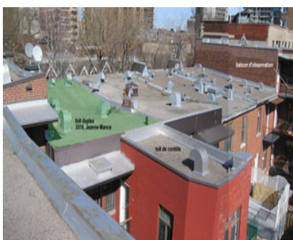
Figure 20.1 Toiture de la coopérative de la Petite cité avant la réalisation du projet pilote de toit vert par le Centre d'écologie urbaine de Montréal. Tirée de Rose, s.d.
