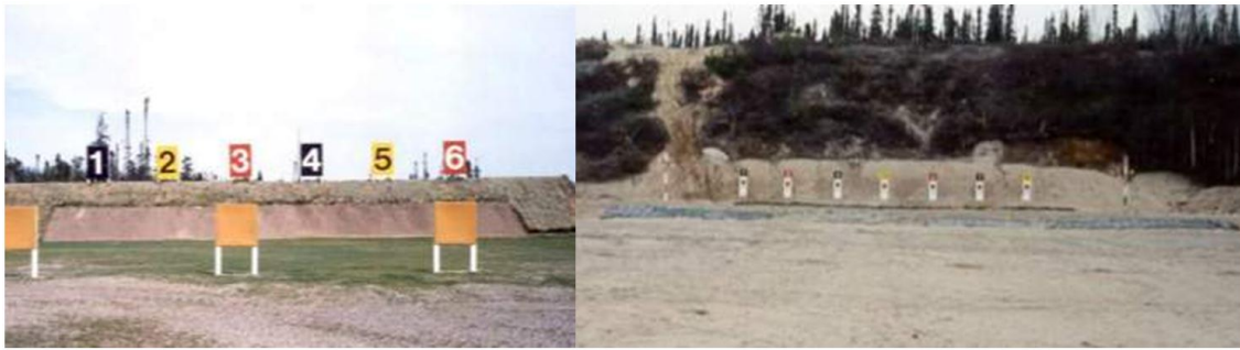
Butte d'arrêt construite
