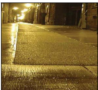
Figure 4.4 Vue d'asphalte perméable aménagée dans la partie centrale de la ruelle Tirée de ville de Chicago (2006), Green Alley Handbook , p.35.
