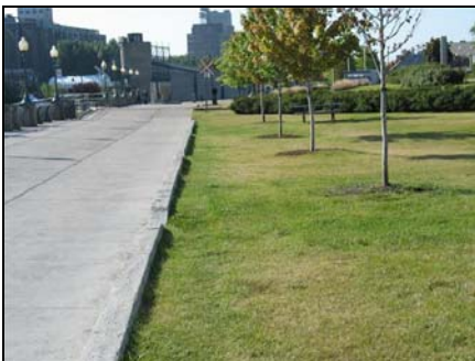
Figure 3.2 Découpe dans une bordure pour faire dévier l'eau vers la verdure Tirée de Direction de l'environnement ville de Montréal (2009)
