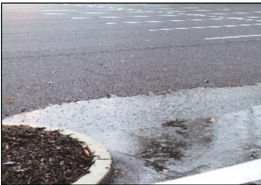
Figure 3.6 Partie de stationnement en asphalte poreux et l'autre en asphalte ordinaire Tirée de Cahil et al. (2008)
