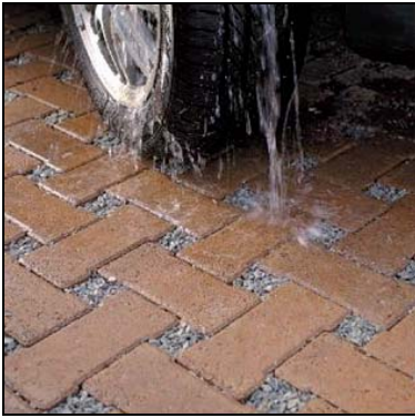
Figure 3.4 Pavés perméables où les espaces sont remplis de gravier Tirée de APEL (2007)
