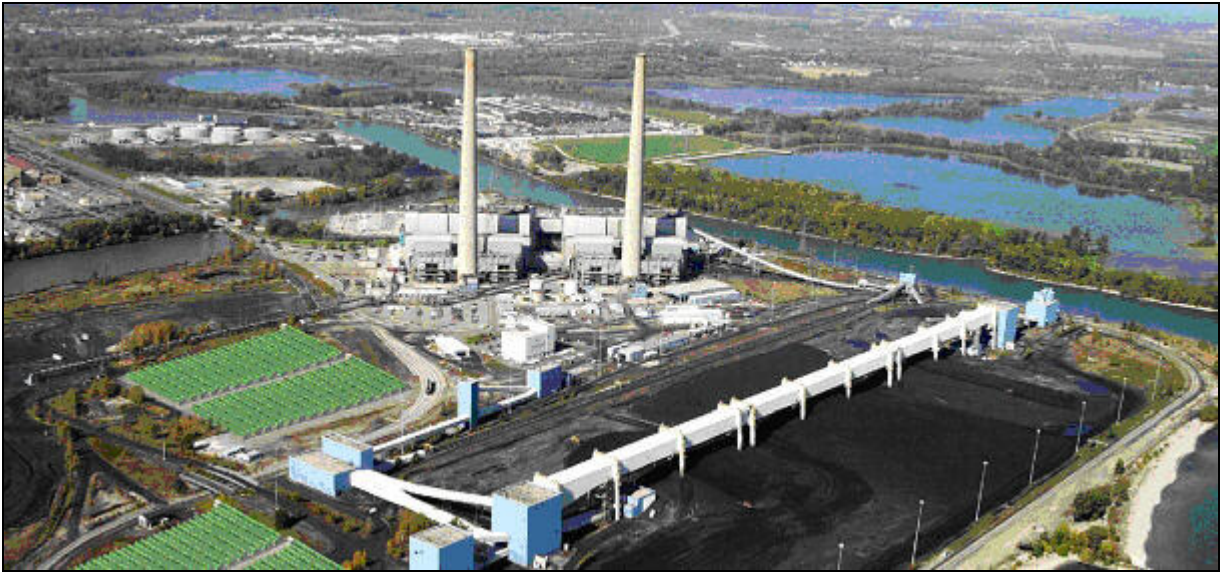
Figure 1.3 Centrale au charbon à cogénération du MIT. (Le \text{CO}_2 qui est capté est conduit aux bioréacteurs à microalgues développés par Green Fuel, visibles en bas à gauche) (Daniélo, 2005).
