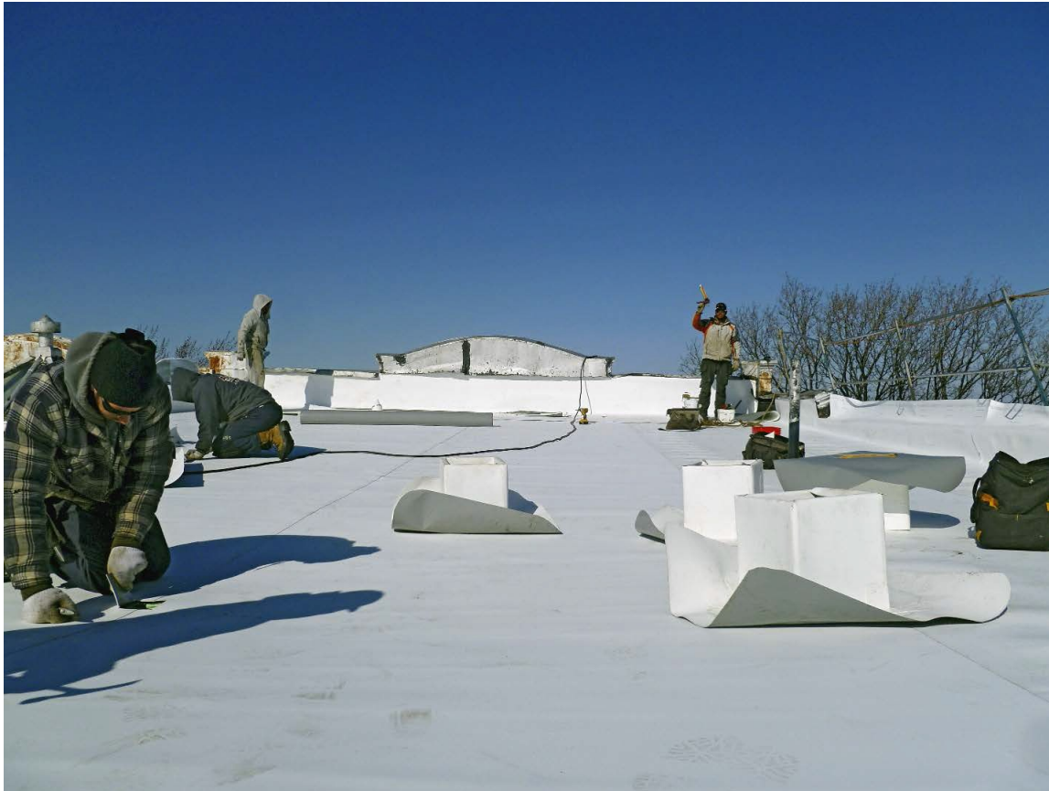
Figure 2.4 Photo d'une toiture blanche dans Rosemont (tiré de : RNC, 2014b)
