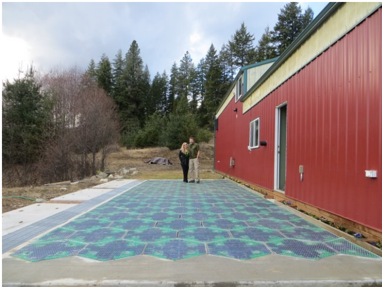
Figure 4.4 Prototype 2 de la route Solaire (tiré de : Brusaw, 2015)
