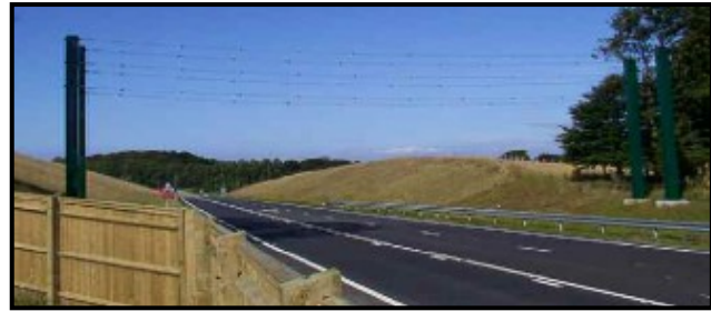
Figure 5.5 : Passerelle aérienne (tiré de : Hinde, 2008, p. 38)
