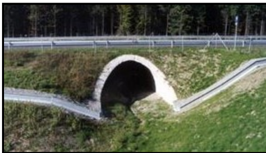
Figure 5.6 : Passage souterrain (tiré de : Bank, 2002, p. 4)
