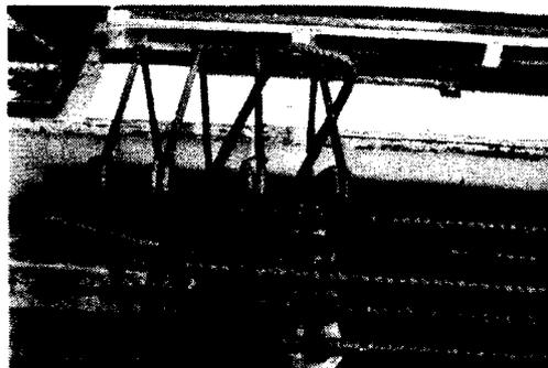
Figure 4-4 : Armature pour la zone d'ancrage
