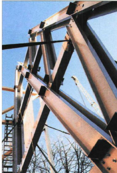
Figure 2.18 Eyecatcher-Forme structurelle adaptée d'une construction de bois traditionnelle-[Keller, 1999]
