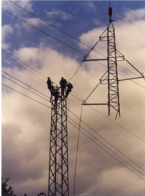
Figure 2.6 Assemblage d'une nouvelle structure compacte avec la structure originale d'un pylône de 66 kV [Cottureau *et al.*, 2002].
