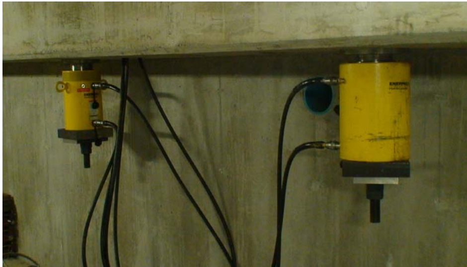
Figure 5-5 : Vérin creux sous la dalle structurale
