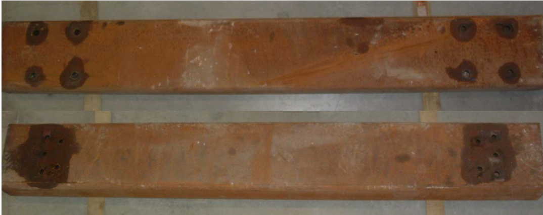
Figure 5-4 : Poutre de transfert entre les vérins et le pylône
