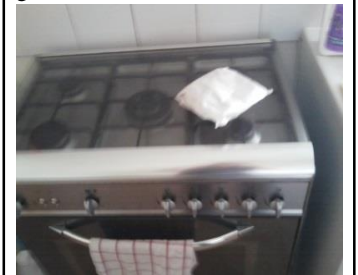
Photo 5 : Appareils de cuisson au gaz sur le Clos du Chandelet
