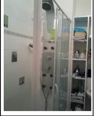
Photo 8 : Douche multi-jets installé à la place d'une baignoire
