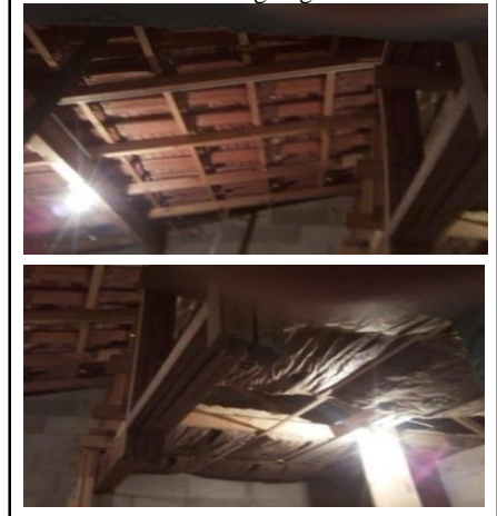
Photo 6 : Toitures des garages mal isolées
