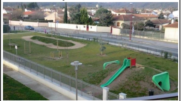
Photo 165 : Aire de jeux du Clos de Chandelet
