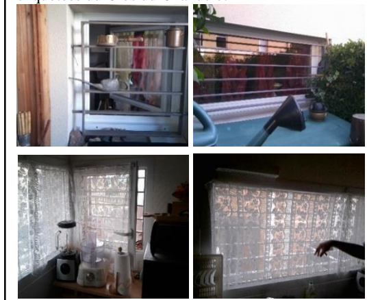
Photo 2 : Fenêtres et baies vitrées critiquées par les enquêtés du Clos du Chandelet
