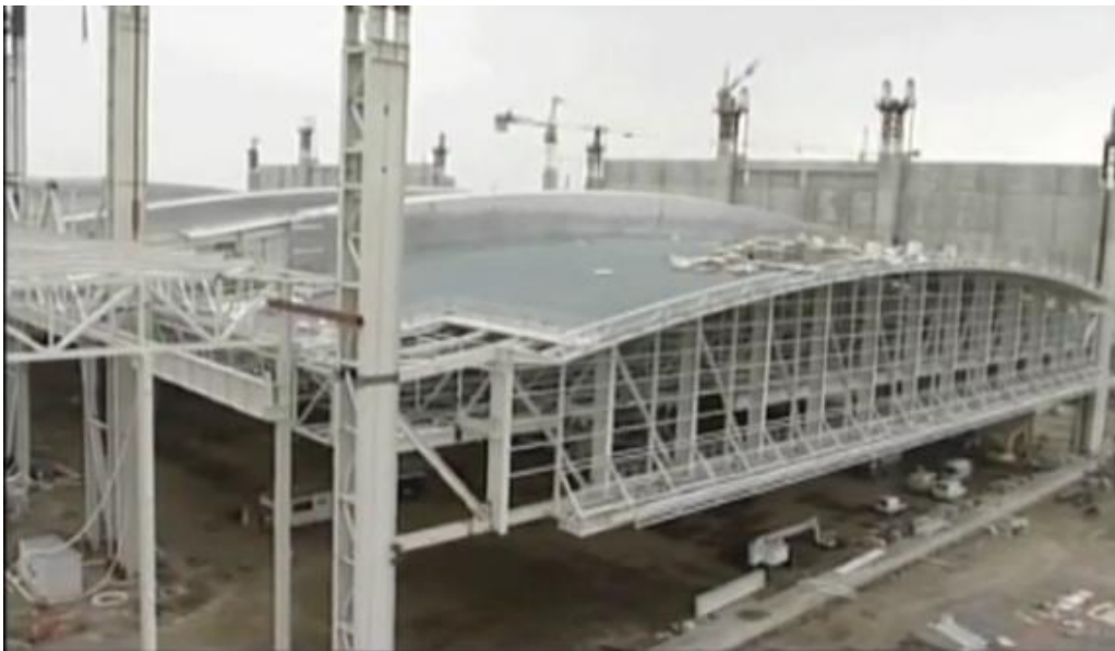
Charpente en cours de hissage (vitesse de 4-5 mètres /heure) Source : vidéo du grand prix national ingénierie 2006
