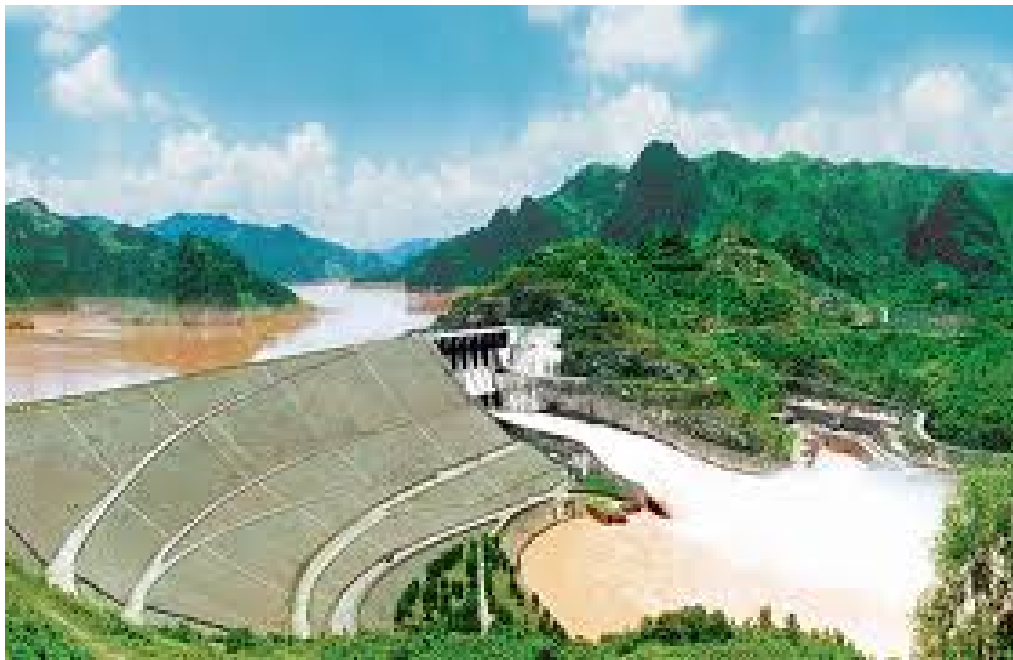
Figure 1. 2: Barrage hydroélectrique de Hoa Binh (source : google images)
