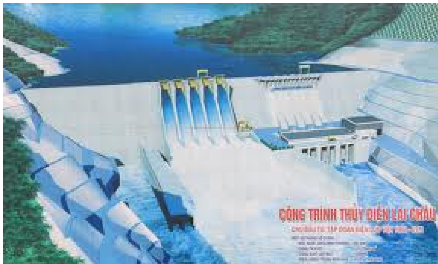
Figure 1. 4: Barrage hydroélectrique de Lai Chau (source : Electricité du Vietnam - EVN)
