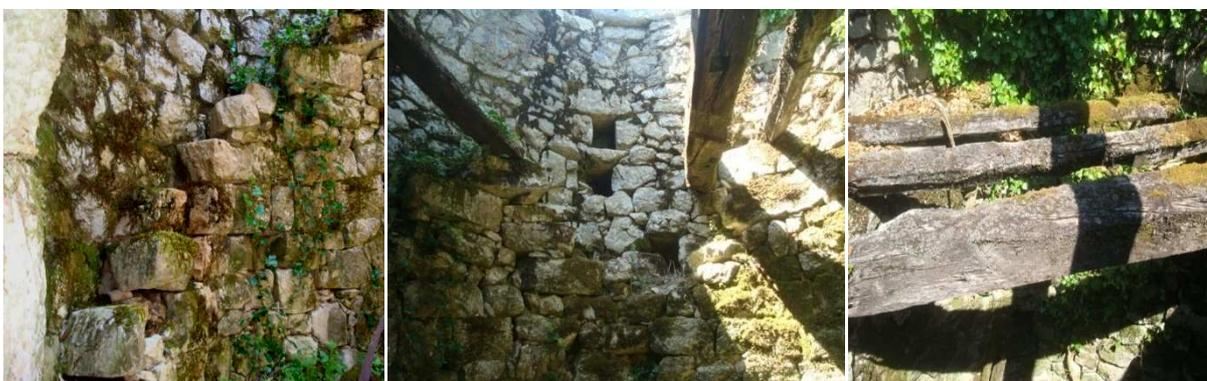
**Figura 28:** Escada de acesso e ruínas das vigas de estrutura do sobrado. (Paulo Ferreira, 2013)
