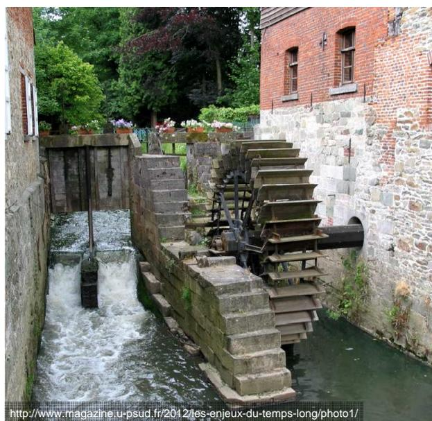
**Figura 52:** Exemplo de aplicação da roda vertical vitruviana.
