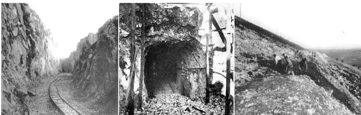
**Figura 131:** Abertura do caminho-de-ferro e do túnel da Serra da Pevide. (Silva, 2007)
