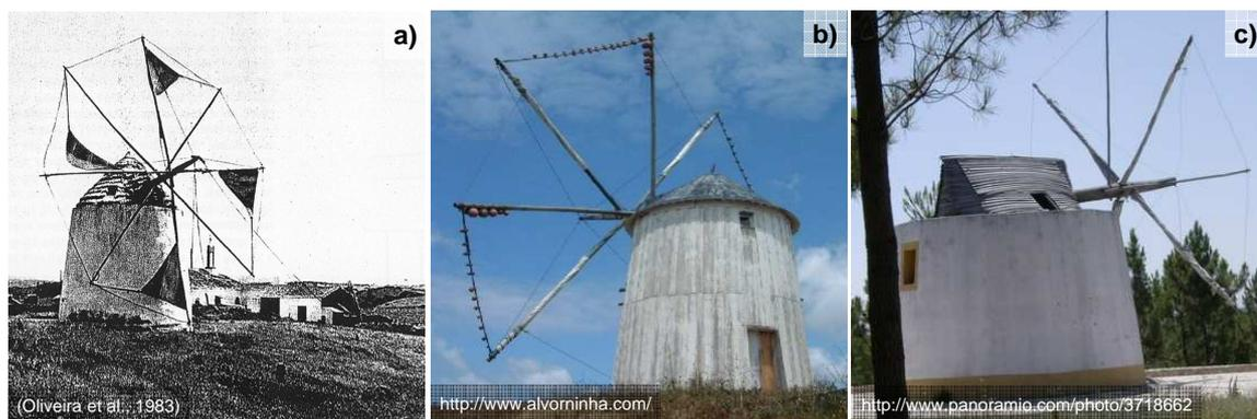
**Figura 56:** a) Moinho de torre fixo de pedra com cabresto (duas pontes). b) Moinho de torre fixo de madeira com sarilho interior. c) Moinho de torre fixo de pedra com cabresto, telhado de duas águas.
