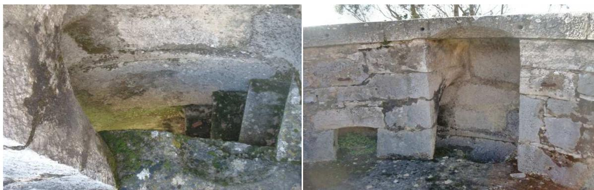
**Figura 76:** Escadas de acesso ao piso superior e postigo com o frechal inferior a servir de padieira. (Idem)
