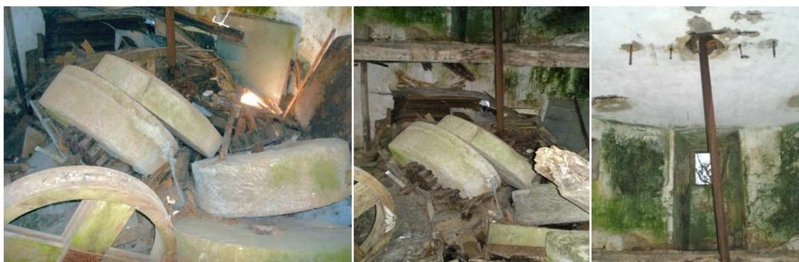
**Figura 73:** Interior do moinho atulhado com mós e varão de ferro que atravessa o piso superior. (Paulo Ferreira, 2013)
