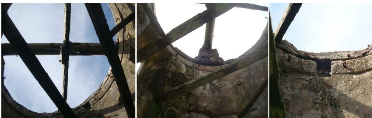
**Figura 51:** Mastro, viga de ponte, chumaceira, frechal superior e postigo no frechal inferior. (Fonte: Idem)
