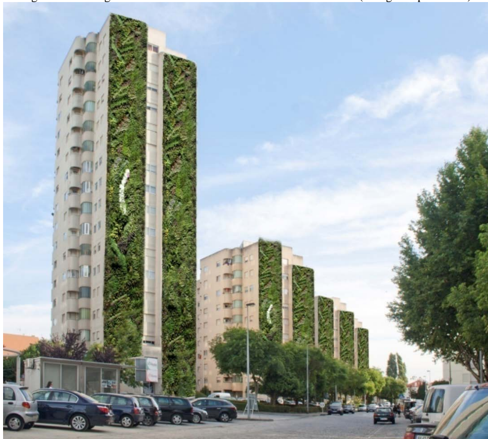
Figura 129 - Aspecto “verde” e natural das torres do bairro de Santa Luzia, através de fotomontagem (Fotomontagem pelo autor)
