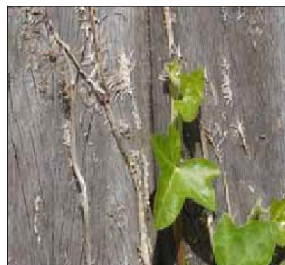
Figura 43 - Exemplo de planta que dispensa estruturas de suporte, sendo a rugosidade da parede suficiente para o seu desenvolvimento (Retirado de: Ottelé, 2011)
