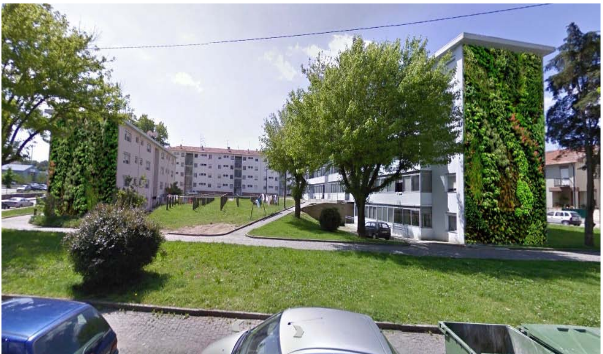
Figura 140 - Resultado “verde” e natural da aplicação de jardins verticais numa empena voltada a Norte do bairro do Outeiro através de fotomontagem (Fotomontagem pelo autor)
