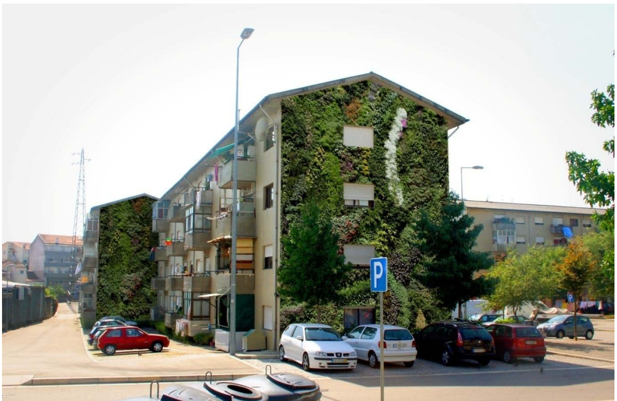
Figura 132 – aspecto “verde” e natural do bloco n.º 10 do bairro de Contumil após a aplicação dos jardins verticais, através de fotomontagem (Fotomontagem pelo autor)
