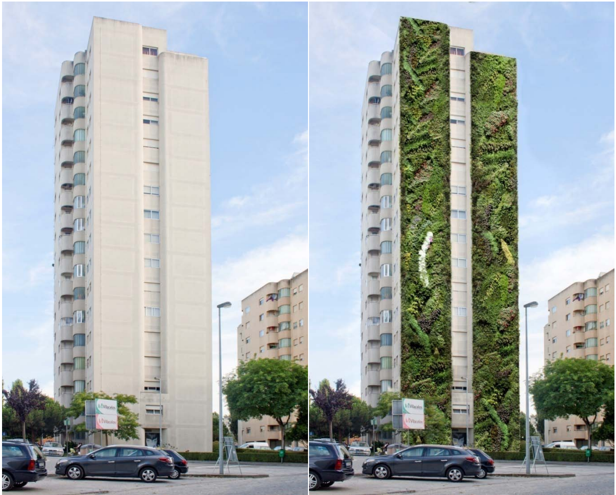
Figura 130 – À esquerda o aspecto actual de uma das torres do bairro de Santa Luzia, à direita o aspecto natural depois da possível introdução da parede viva (Fotomontagem pelo autor)
