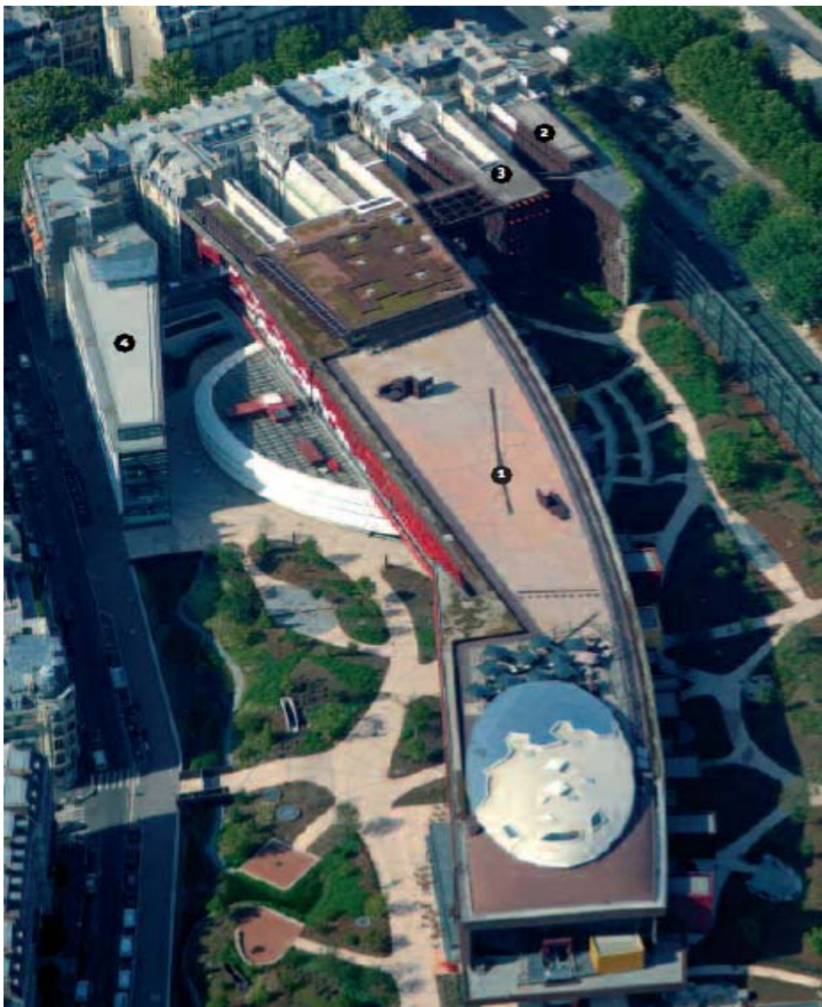
Figura 88 - fragmentação do edifício em 4 partes, através da sua diferente arquitectura e das diferentes funções que contempla. A parede viva da autoria de Patrick blanc encontra-se no 2º fragmento, correspondente á parte administrativa do museu (Retirado de: Quai Branly, 2006)
