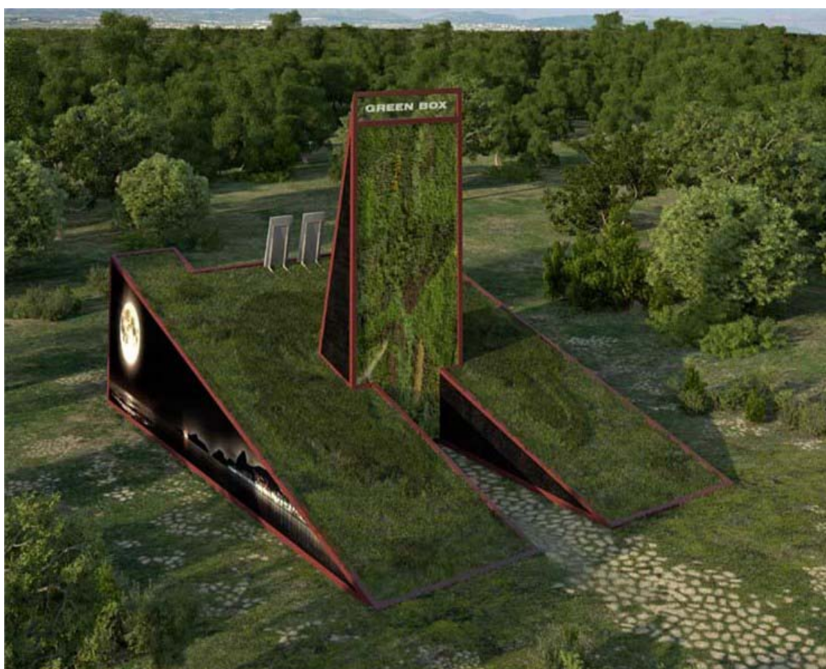
Figura 78 - A Green Box, onde se destaca o seu Jardim Vertical, assim como a sua cobertura inclinada e a jardinada (Retirado de: Garrido, www.archilovers.com , 2009)
