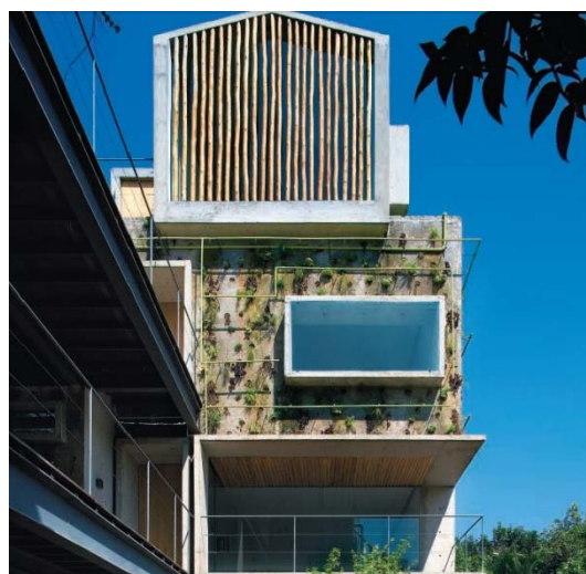
Figura 62 - sistema de rega pouco vulgar e muito original, usado no edifício Harmonia 57 em São Paulo (Retirado de: Barahona, 2009)
