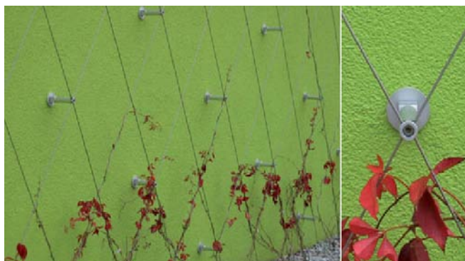
Figura 46 - Crescimento das plantas através de um sistema de cabos em aço (Retirado de: Carl Stahl , 2008)
