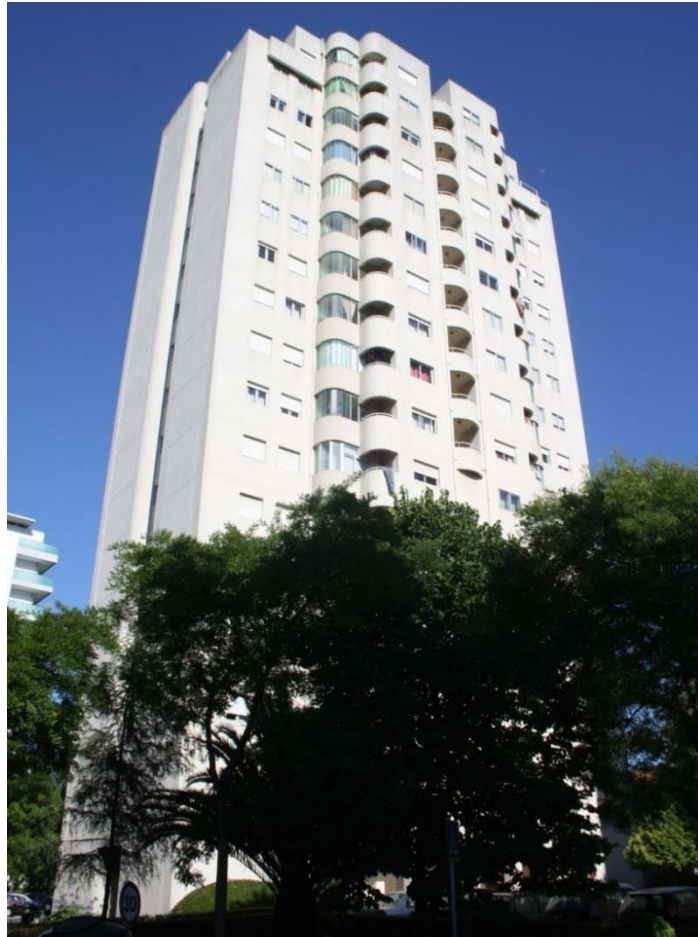
Figura 116 - Aspecto da fachada poente de uma das torres do bairro de Santa Luzia. Destaque para o uso do reboco de argamassa de cimento e posterior pintura na sua fachada. Destaque ainda para a fachada voltada a Norte (à esquerda), característica pela sua quase ausência de vãos, características propícias à aplicação dos jardins verticais (fotografia pelo autor)
