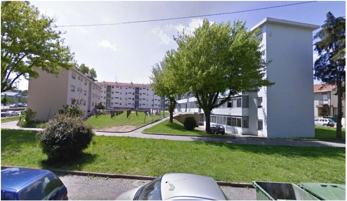
Figura 139 - empenas do bairro do Outeiro voltadas a Norte, propicias para a aplicação de jardins verticais (Fotografia pelo autor)
