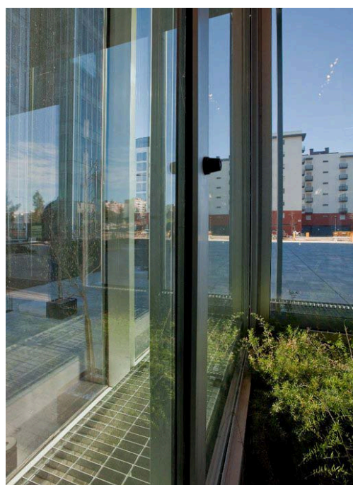
Figura 74 - A fachada dupla na presença de vegetação no seu interior permite um controlo exemplar na temperatura do ar (Retirado de: Natura Towers, 2011)
