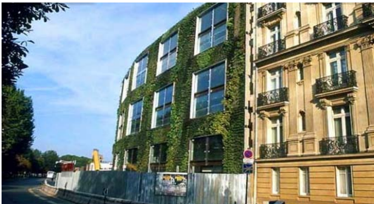
Figura 89 - Nesta parte do museu, destaque para a parede viva, assim como para a curvatura da fachada e seus vãos de generosas dimensões (Retirado de: Lee, 2011)
