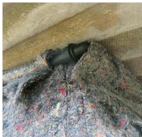
Figura 61 - Tubo de abastecimento de rega escondido por de trás do feltro de plantação (Retirado de: Vialard, 2010)
