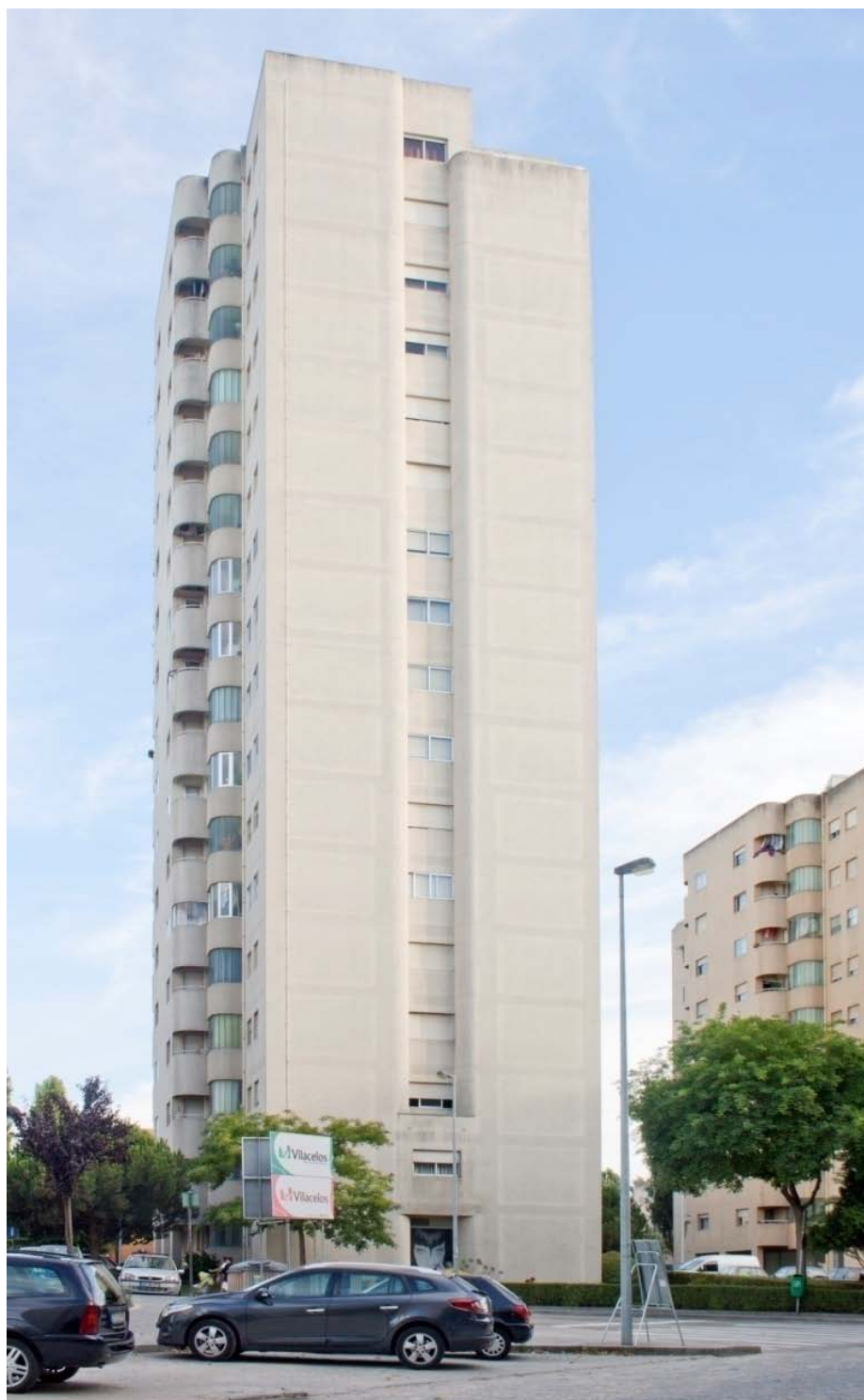
Figura 124 - A estrutura de betão das torres de Santa Luzia é extremamente simples, sendo perceptíveis os pilares e vigas quando observadas. Este facto torna-se importante na medida que simplifica a aplicação dos jardins verticais (fotografia pelo autor)
