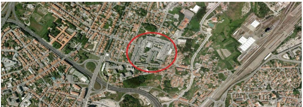
Figura 117 – Imagem aérea do bairro de Contumil, assinalado a vermelho. Próximo de importantes vias de comunicação como a VCI e a linha férrea (Retirado de: https://maps.google.pt ).
