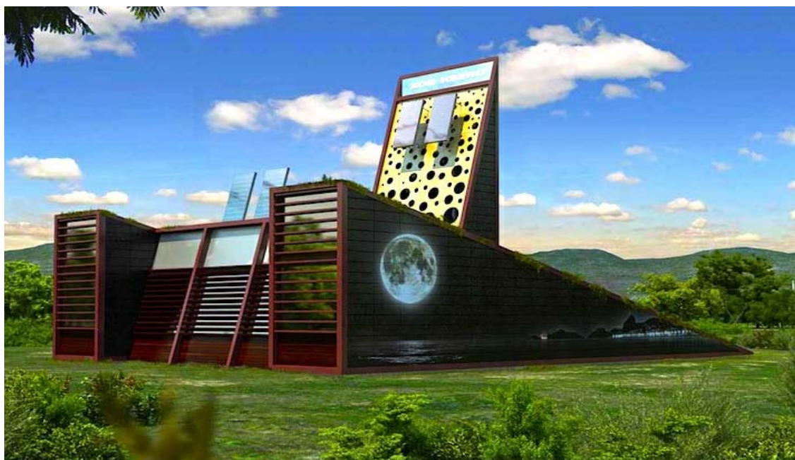
Figura 82 - Para além dos Jardins Verticais, destacam-se outros elementos sustentáveis no edifício, como os painéis solares e a forte exposição solar Sul (Retirado de: Laylin, 2009)
