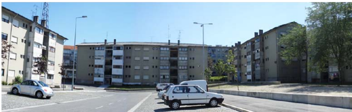
Figura 121 – Aspecto do revestimento do edificado do bairro de Contumil (retirado de: Pedrosa, 2010).
