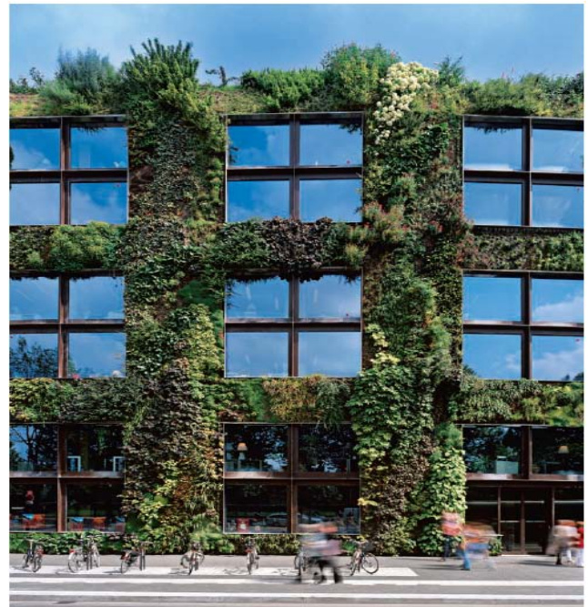
Figura 37 - É um dos edifícios mais conhecidos de Jean Nouvel, sendo a sua Parede Viva o elemento característico do Projecto (Retirado de: Barahona, 2009)
