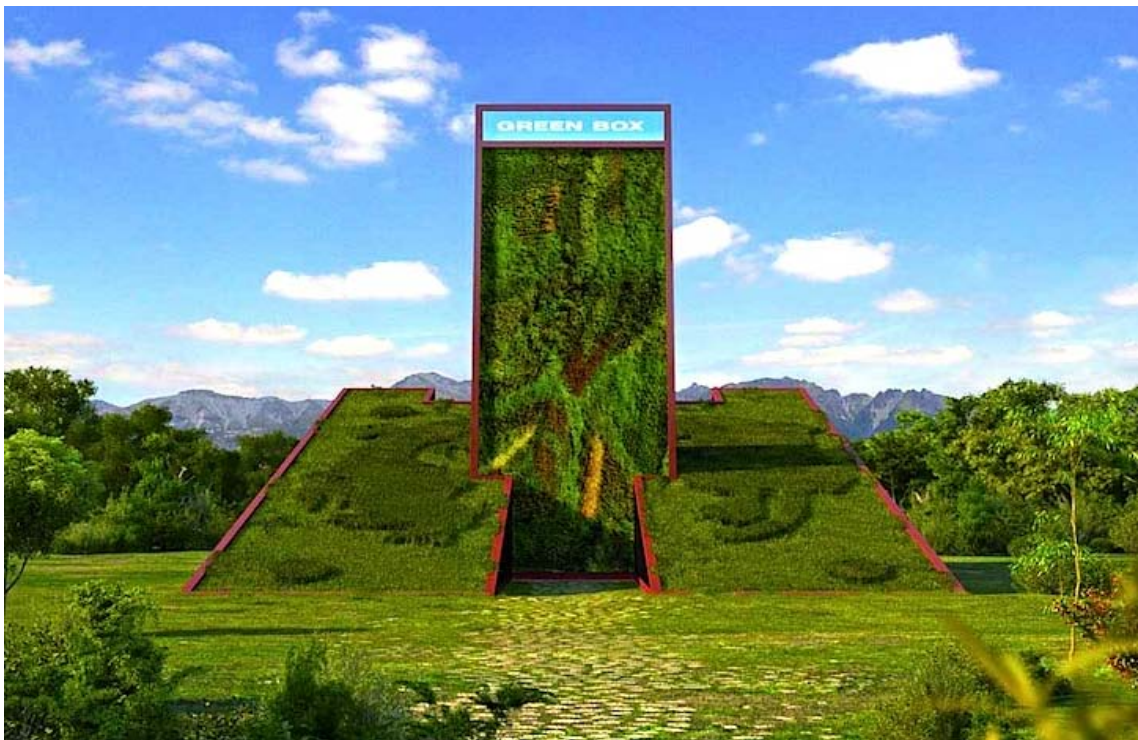
Figura 79 - Aspecto verde da Green Box, onde se destaca a sua cobertura inclinada, como continuação do jardim, e o seu Jardim Vertical na torre central do edifício (Retirado de: Laylin, 2009)
