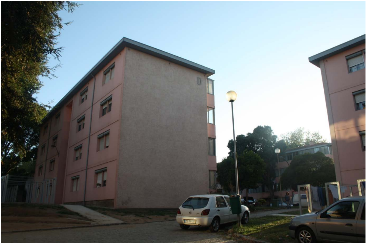
Figura 142 – empena do bairro da Agra do Amial voltada a Norte, propicia para a aplicação de jardins verticais (Fotografia pelo autor)
