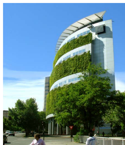
Figura 39 - No Chile, este destaca-se pela utilização de Fachadas verdes plantadas em caixas de substrato em 3 níveis (Retirado de: www.plataformaarquitectura.cl )
