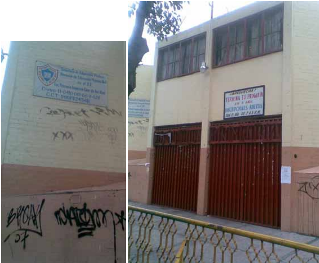
Figura 48. Fachada principal de la Escuela Primaria Francisco Giner de los Ríos.
