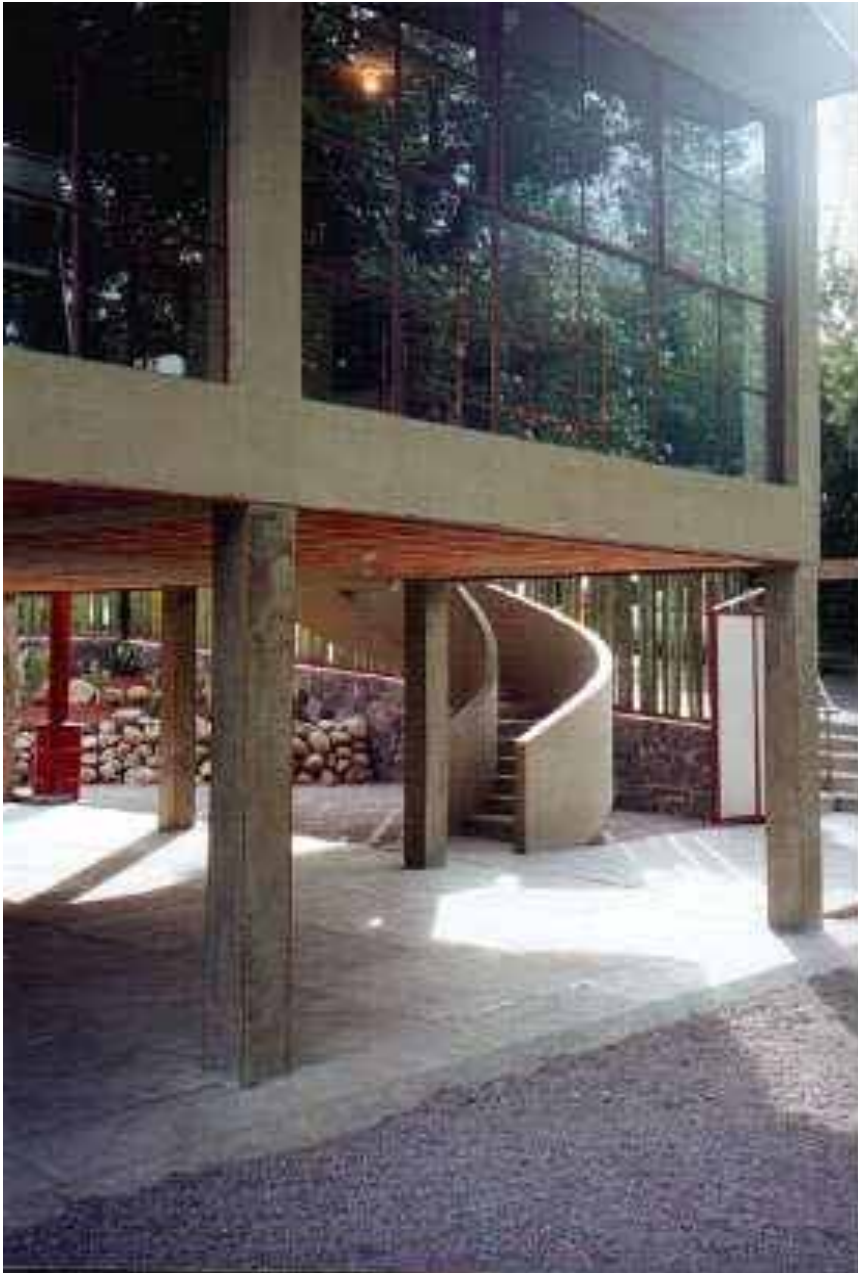
Figura 79. Planta libre, funciona como terraza cubierta, 2008
