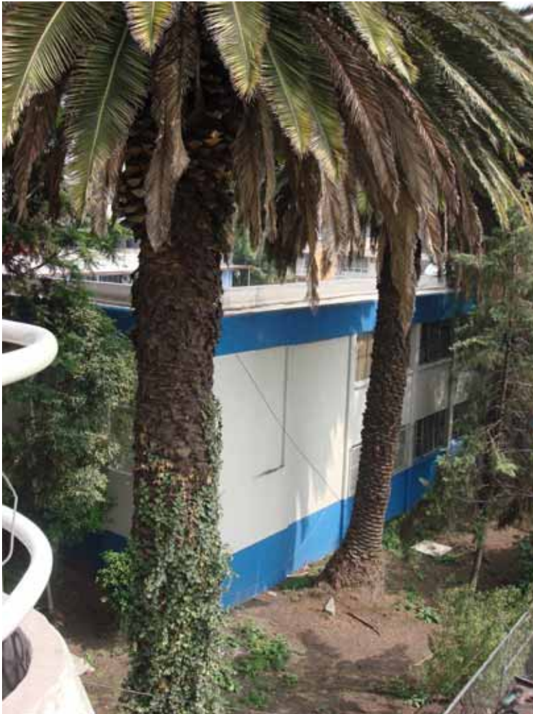
Figura 36. Espacio que se crea por la escuela aislada, colindante con calzada de Tlalpan de la escuela Carlos A Carrillo.
