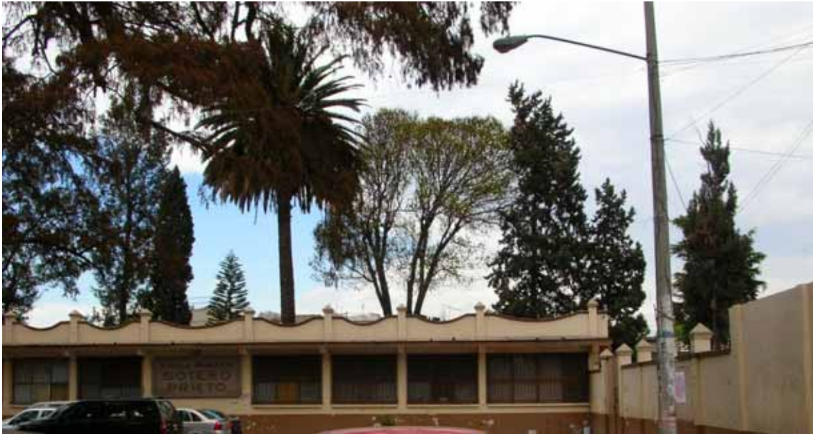
Figura 60. Fachada de la escuela Sotero Prieto del lado derecho se ve la fachada principal sur, donde se encuentra actualmente el acceso.
