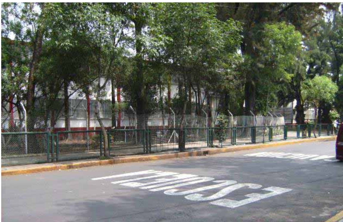
Figura 43. Fachada principal Biblioteca pública de la escuela Enrique Rodó 2008.
