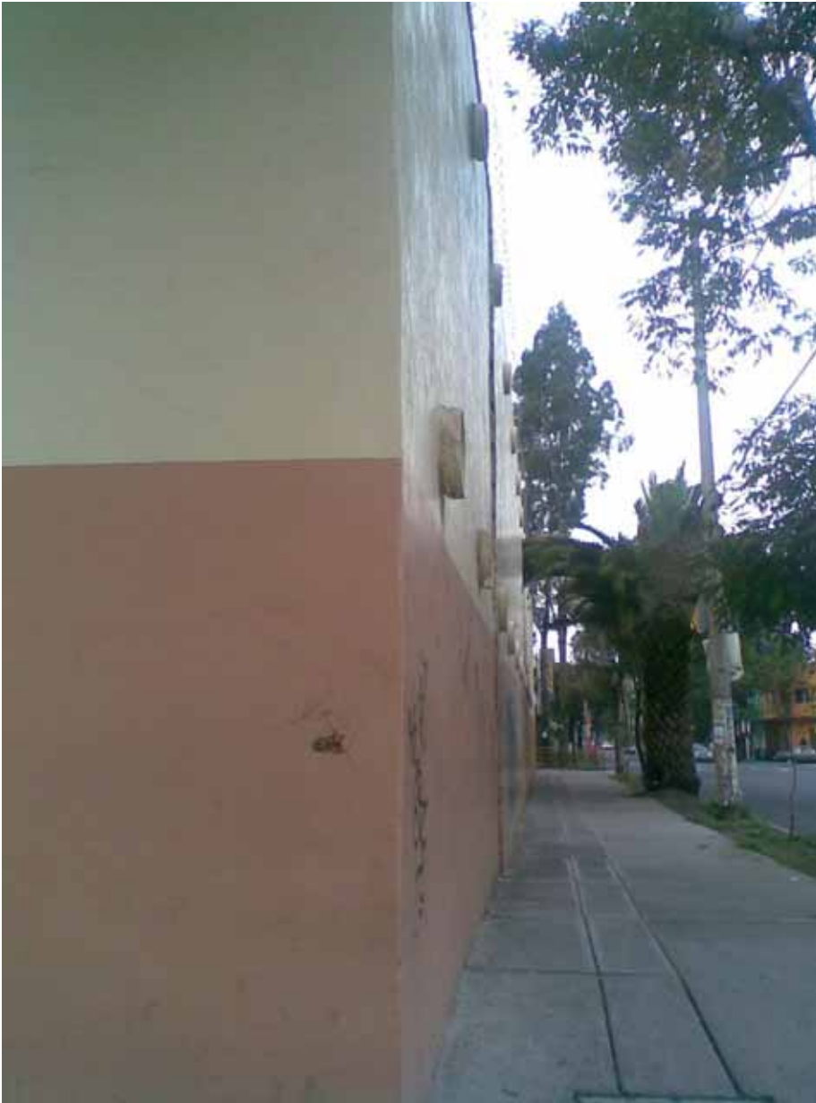
Figura 50. Fachada lateral de la escuela primaria Giner de los Ríos.
