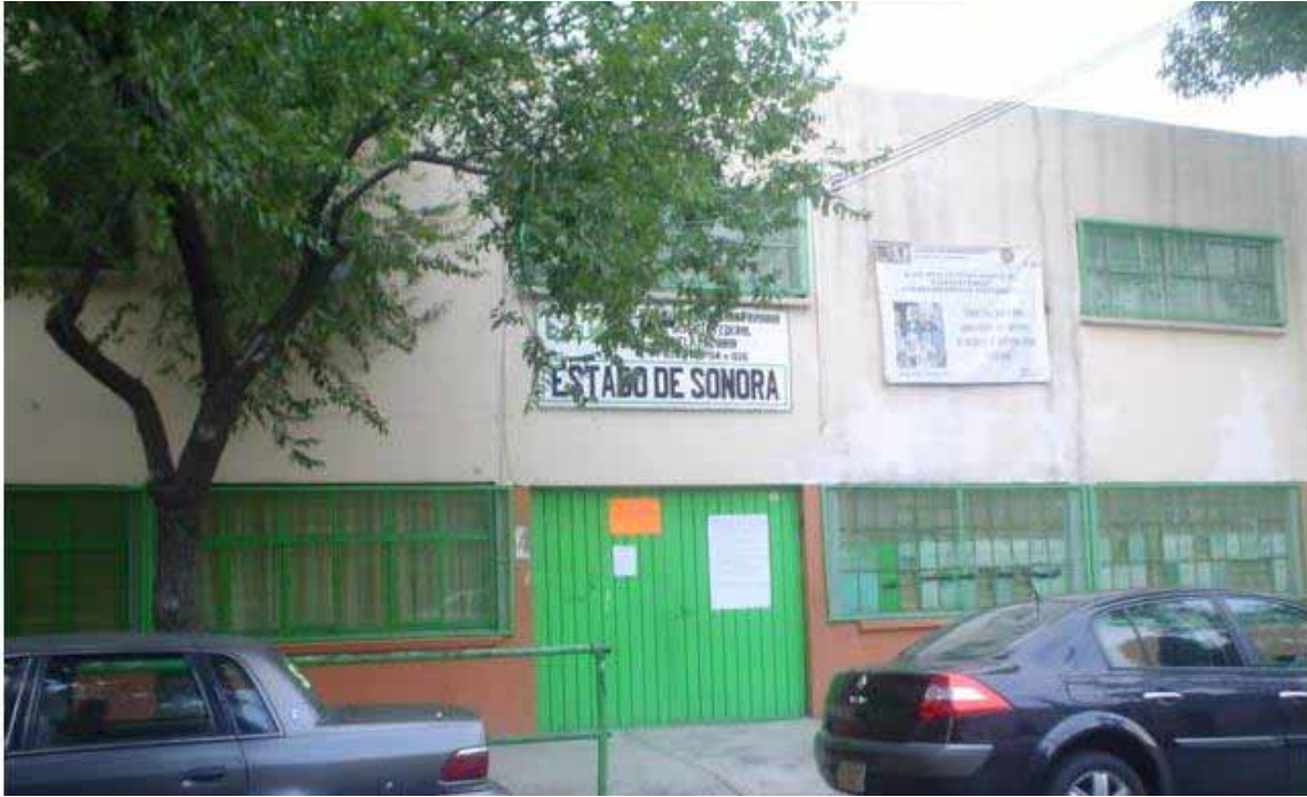
Figura 44. Fachada principal de la Primaria Estado de Sonora.
