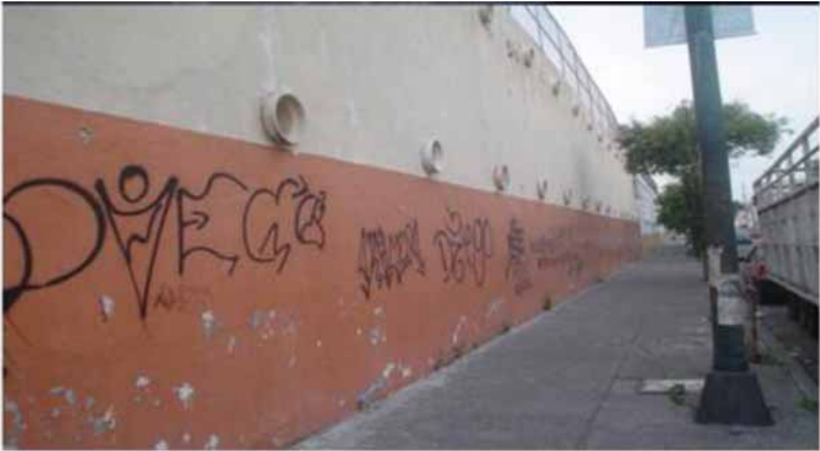
Figura 46. Fachada lateral de la escuela primaria Estado de Sonora. 2008
