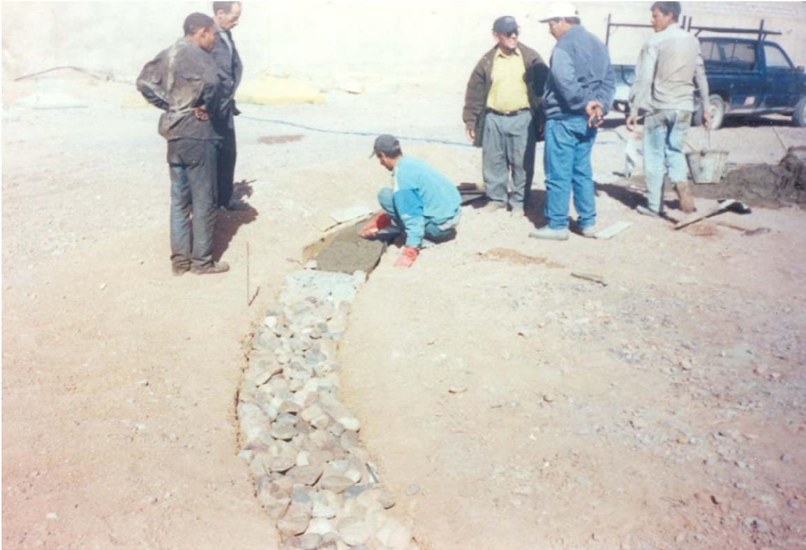
Figure 149. Construction de la piste circulaire d'appui de la poutre de chargement
