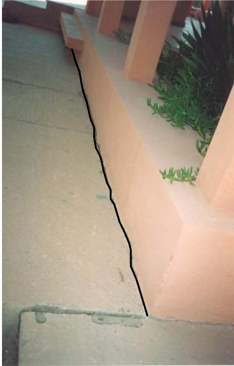
Figure 23. Détachement d'origine thermique du perré bétonné et de la semelle filante, ouverture de la fissure puis infiltration de l'eau dans le sol sous-jacent (Bâtiment administratif du ministère des finances, Ouarzazate)
