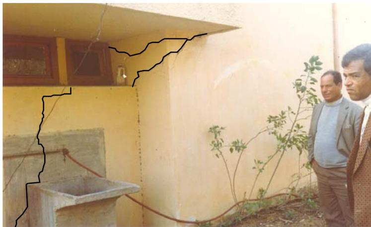
Figure 26. Soulèvement des fondations du fait de l'installation incorrecte du point d'hygiène
