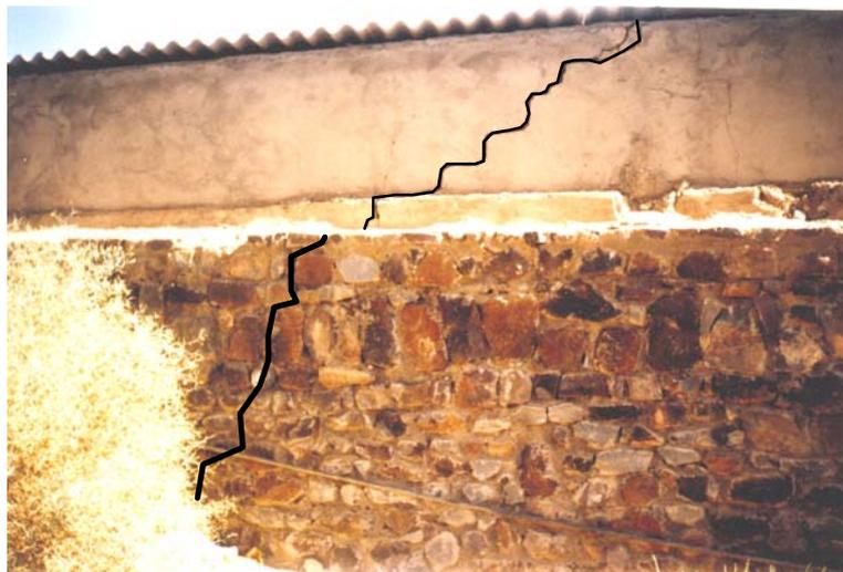
Figure 21. Fissuration du mur d'un dépôt de matériaux du fait du gonflement du sol (ONEP, Ouarzazate)
