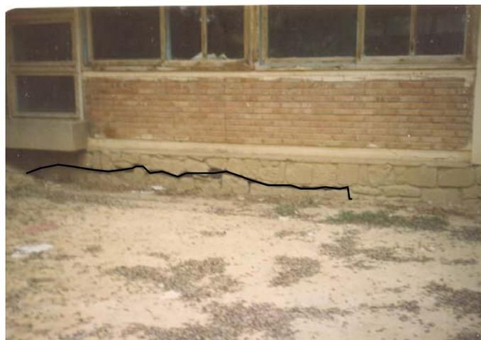
Figure 46. Tassement différentiel du terrain au dessous d'une fondation (Fès)
