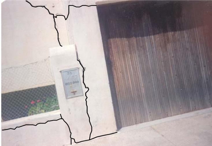
Figure 41. Soulèvement d'une fondation lors de l'imbibition du sol sous le centre de la fondation (Safi)
