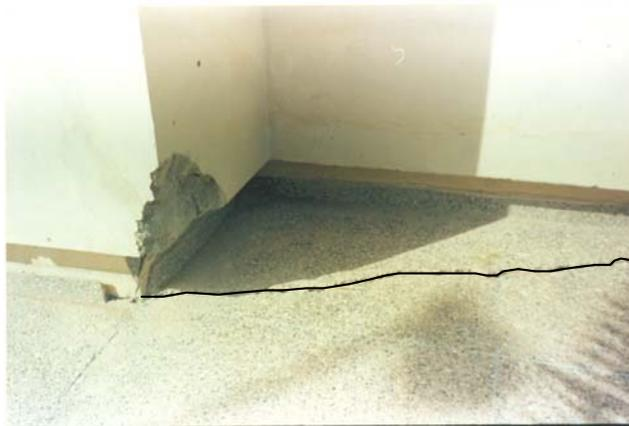
Figure 37. Rupture du trottoir en béton du fait du gonflement du sol (Office National des Eaux, Ouarzazate)
