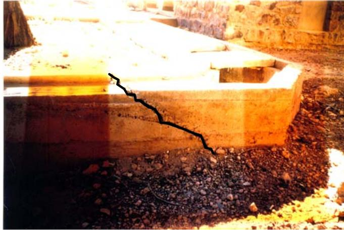
Figure 32. Rupture du canal en béton du fait du gonflement différentiel du sol (Lycée de Ouarzazate)
