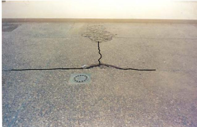
Figure 34. Soulèvement local de la dalle en béton du fait de l'infiltration de l'eau d'une canalisation (Office National des Eaux, Ouarzazate)
