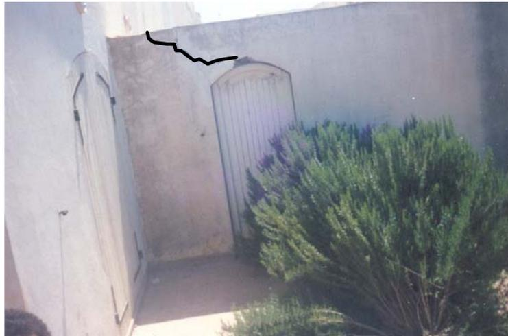
Figure 25. Soulèvement des fondations du fait de l'installation d'un jardin (Safi)
