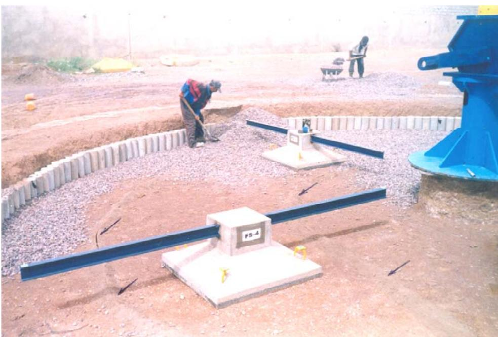
Figure 160. Mise en place de la couche de gravier
