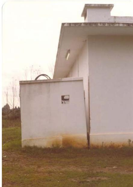
Figure 45. Tassement différentiel du terrain sous les fondations d'une station de pompage (SP13, Garb)
