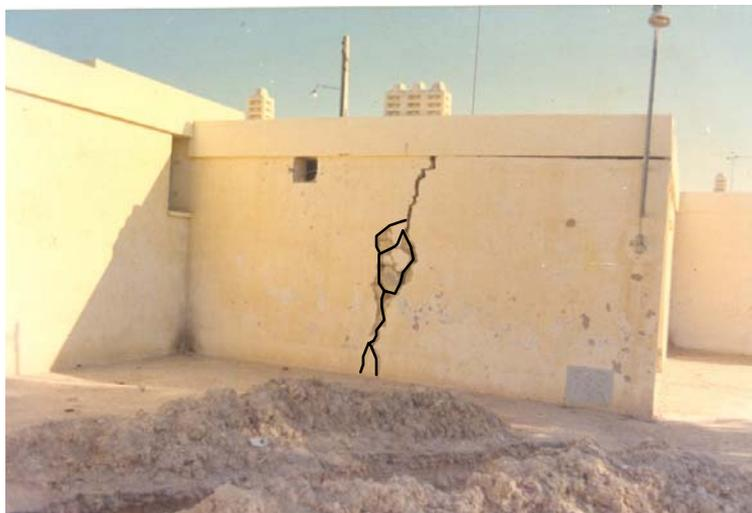
Figure 44. Tassement différentiel du terrain au dessous de la fondation d'un mur (Oued Zem)
