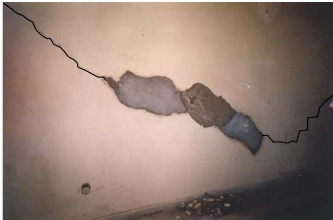
Figure 30. Ouverture d'une fissure dans un mur en maçonnerie du fait du gonflement différentiel du sol (Lycée de Ouarzazate)
