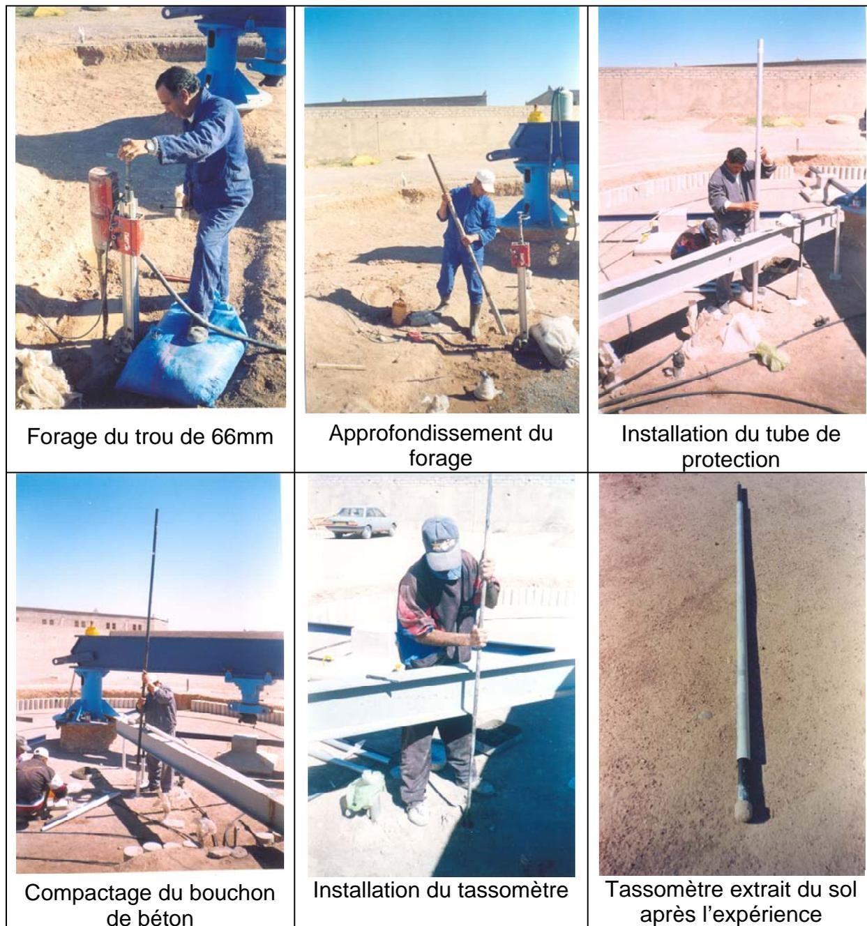
Figure 153. Vues des travaux d'installation des tassomètres sur le site expérimental
