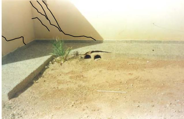
Figure 36. Soulèvement et rupture du trottoir bétonné du fait de l'humidification du sol gonflant (Office National des Eaux, Ouarzazate)
