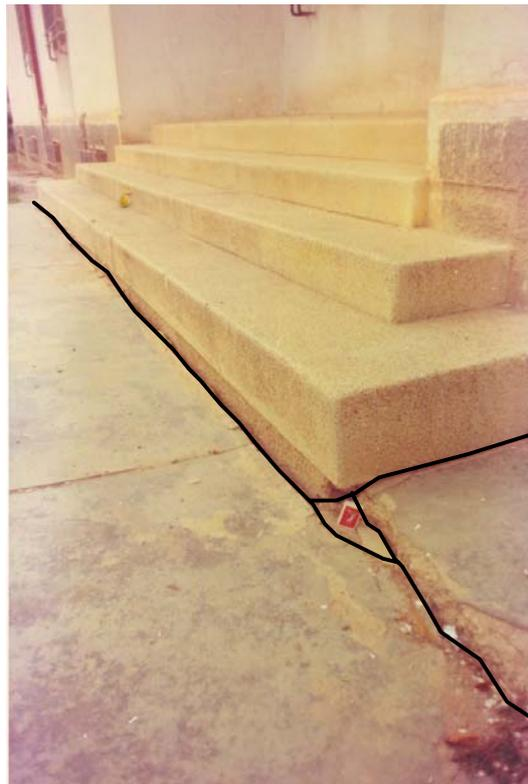
Figure 47. Tassement différentiel du terrain sous une dalle en béton (Fès)
