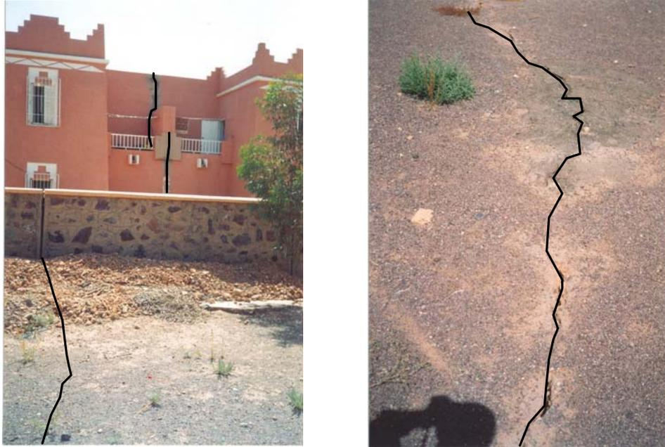
Figure 20. Fissuration du bâtiment des douanes du fait de la migration de l'eau du collecteur d'eaux superficielles de l'ONEP
