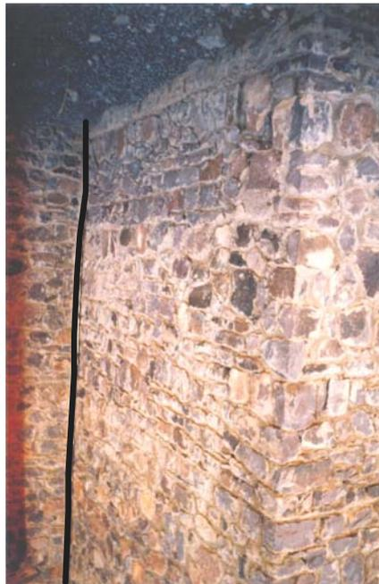
Figure 31. Ouverture du joint de tassement du fait du gonflement différentiel du sol (Lycée de Ouarzazate)
