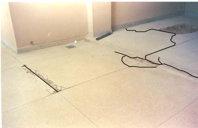
Figure 35. Soulèvement et rupture de la dalle en béton du fait de l'infiltration de l'eau d'une canalisation (Office National des Eaux, Ouarzazate)
