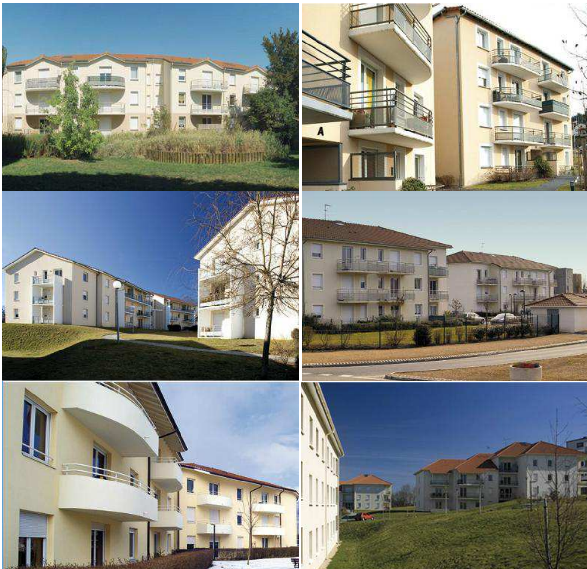
Figure n°60 : Exemples d'opérations du groupe Akerys (à Bellerive-sur-Allier en 2003, au Puy-en-Velay en 2005, à Limoges en 2004, à Saint-Laurent-sur-Saône en 2004, à Vetraz-Monthoux en 2003 et à Guéret en 2005)
